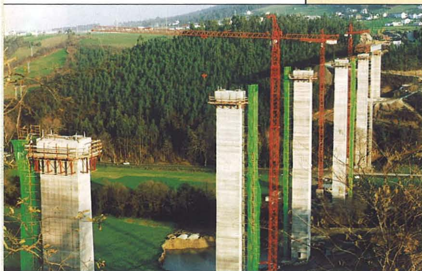
Viaducto de San Timoteo en fase de construcción.
