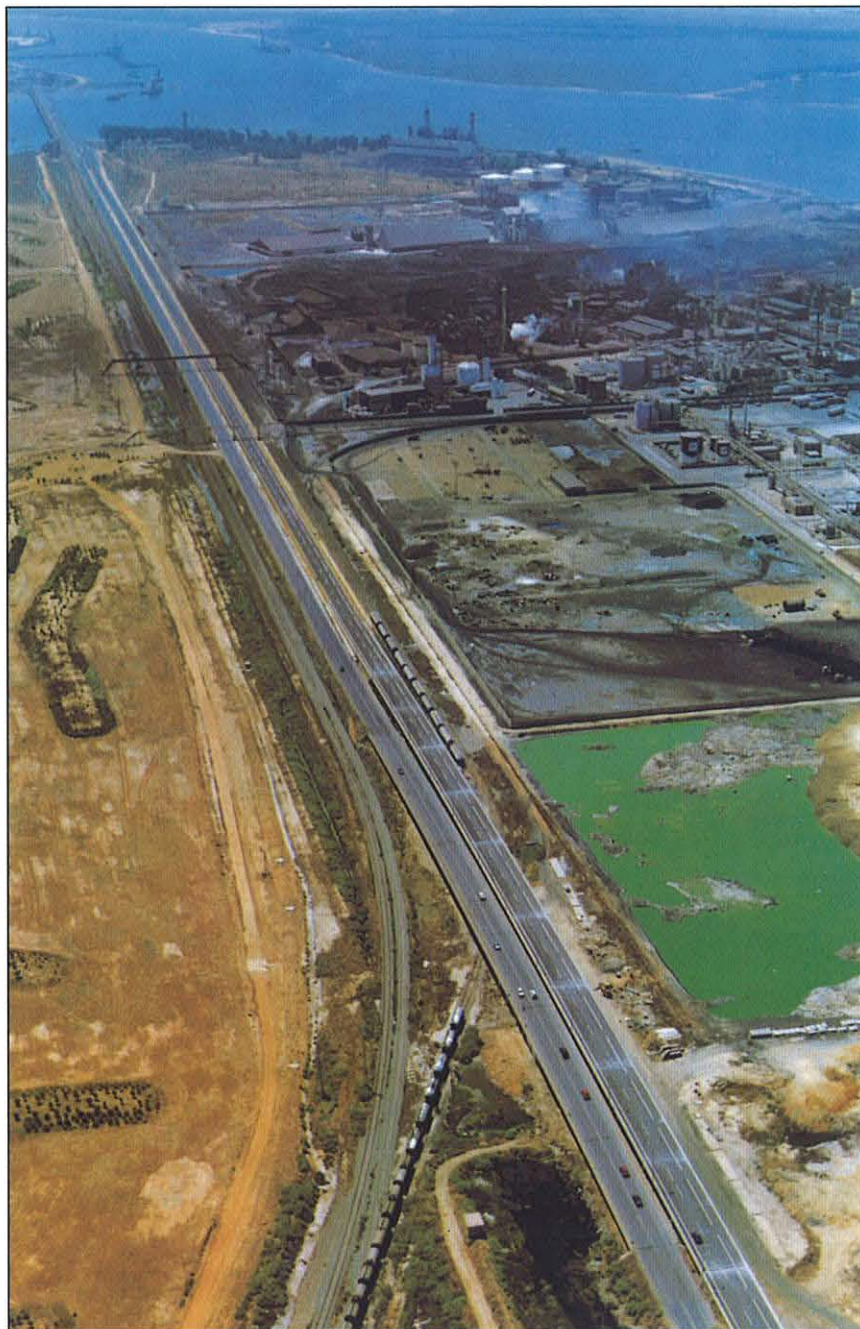
La longitud total del tramo alcanza los 2 819 m.
