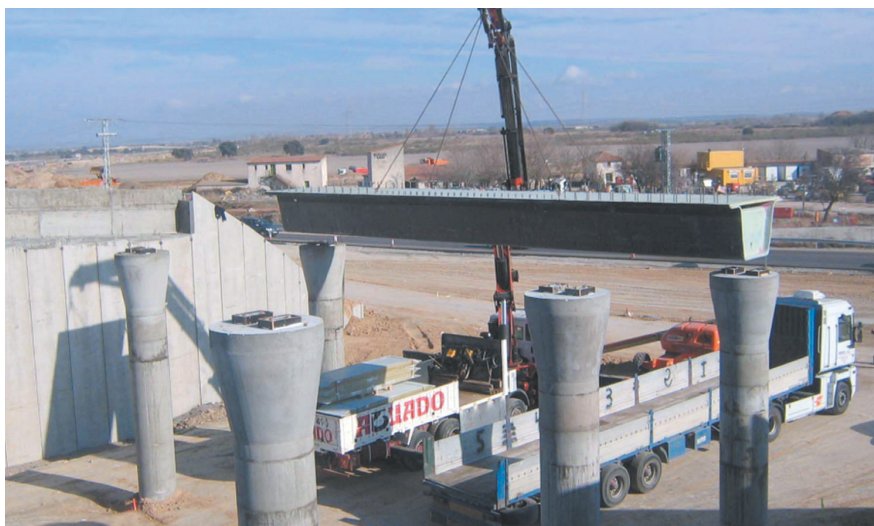
Detalle del montaje de las vigas y las prelosas.
