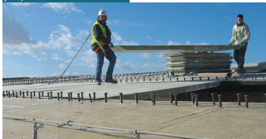
Detalle del montaje de las vigas y las prelosas.
