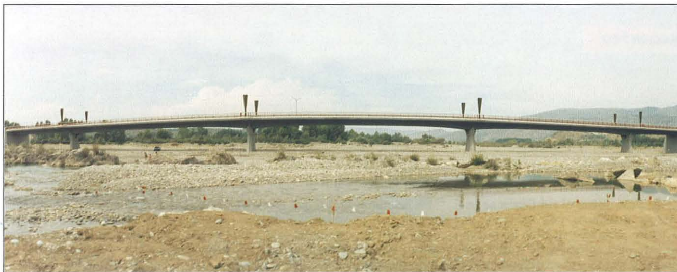
La imagen nos muestra el puente, diseñado con viga continua, tipo cajón unicelular con canto variable
