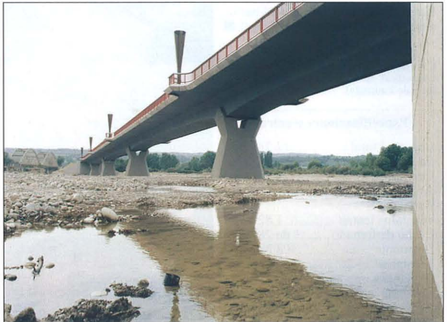
La altura del puente oscila entre los 6,40 m de la pila más corta hasta los 10,18 m del estribo frontal
