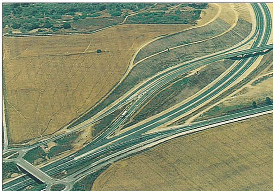
Taludes en Sierra de San Cristóbal
