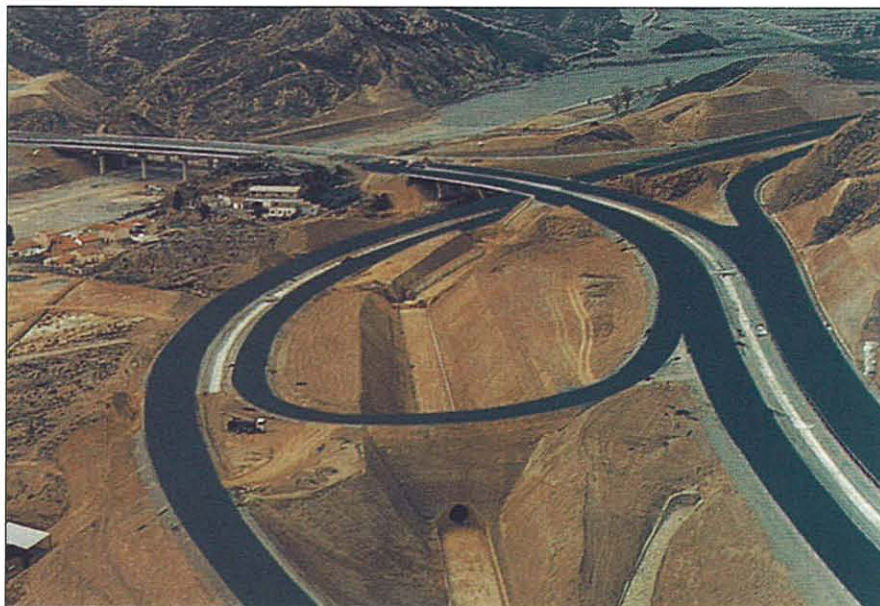
La variante se ha ejecutado anticipando dos meses su plazo de finalización oficial
