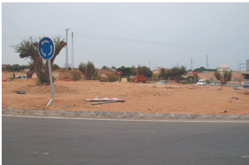
Las incontables huellas de neumáticos, de golpes y de restos de vehículos en la isleta central de esta glorieta, indican que el fallo está en el diseño, en la señalización y en el balizamiento, provocando una percepción tardía.
