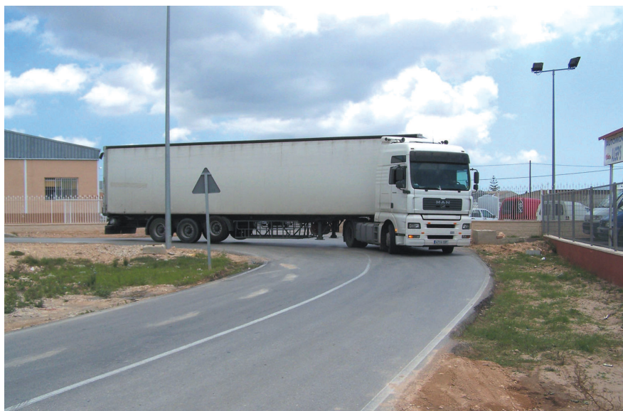
Un riesgo innecesario y absurdo, es una vía de servicio de doble sentido construida sin tener en cuenta el radio de giro de los vehículos, la colisión frontal sólo es cuestión de tiempo y será con vehículos ligeros.
