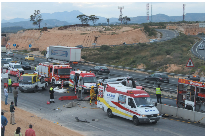
Las barreras “New Jersey” sólo sirvieron para conducir el vehículo a un impacto mortal contra la barrera de hormigón. Si toda la barrera hubiera sido uniforme en cuanto a su resistencia, se hubiese salvado.
