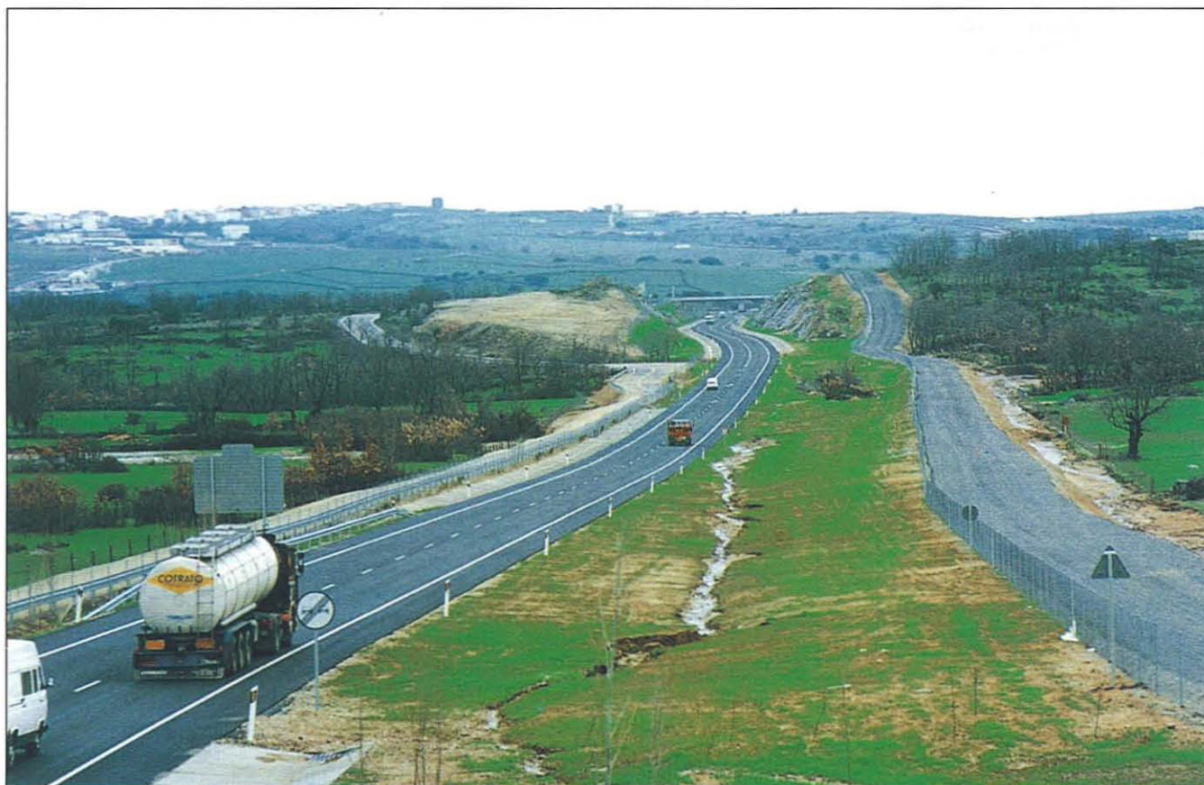
Tramo Guijuelo - Béjar (Norte), Vista parcial
