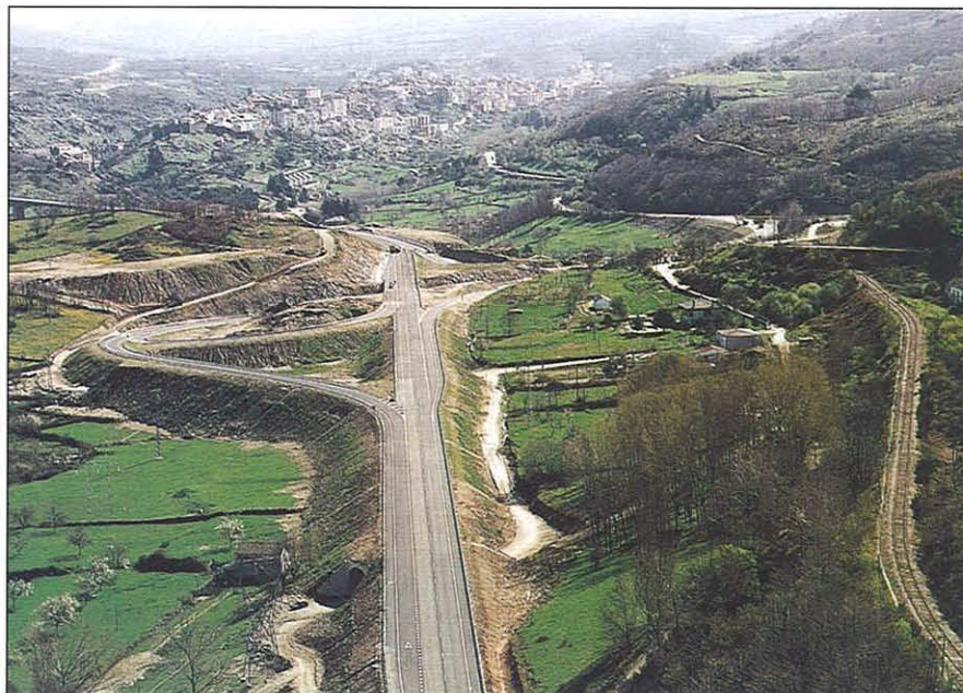
La longitud de esta obra es de 6,1 km, con un tramo de vía lenta de 1,4 km
