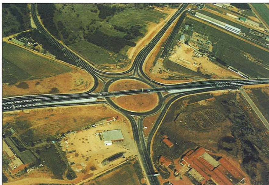
El tramo inaugurado tiene 3 900 m de nueva carretera
