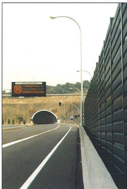
Detalle de pantallas antirruido, luminarias y entrada a los túneles
