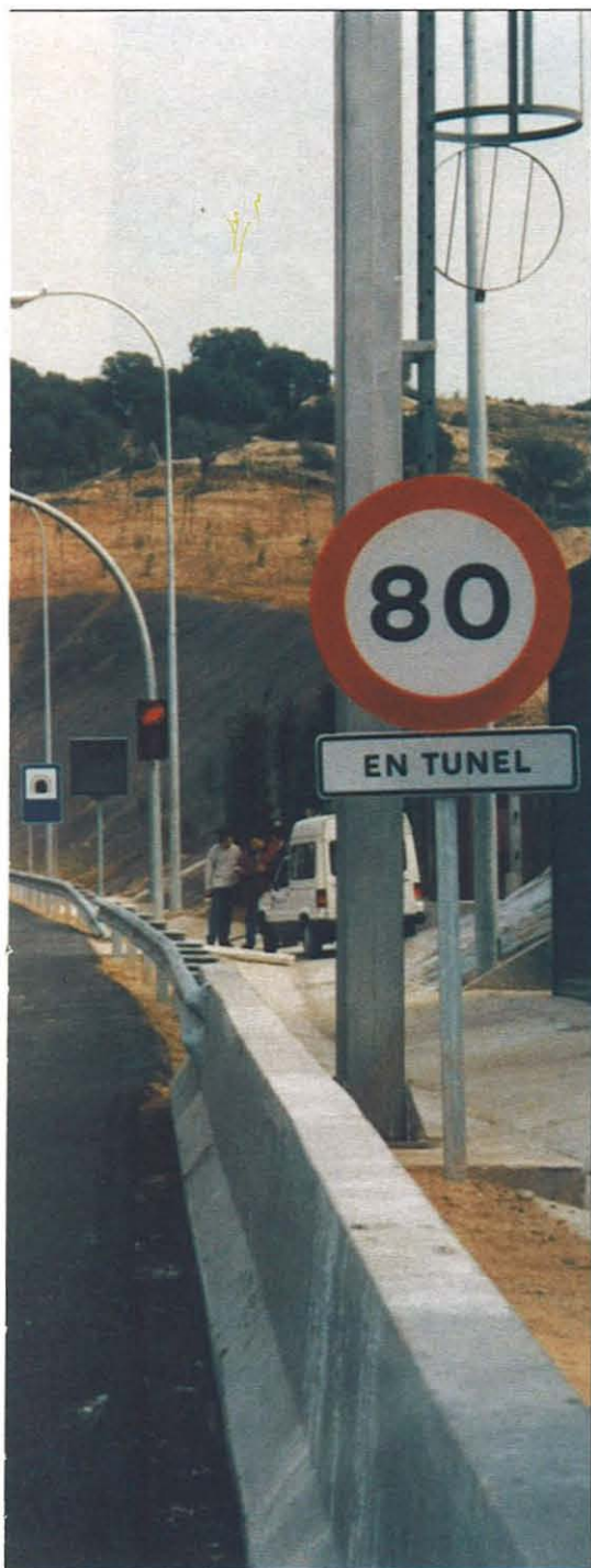
Túneles de El Pardo
