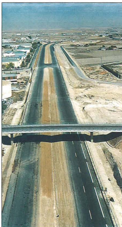
Vista parcial del tramo durante las obras
