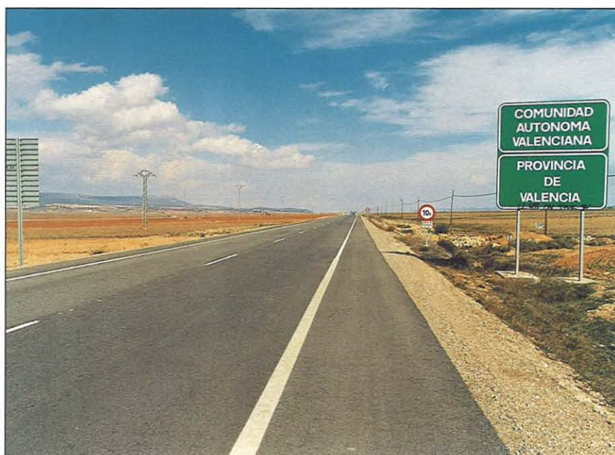
La obra realizada tiene una longitud de 16 km, con sección transversal de 2 carriles de 3,5 m, uno por cada sentido de circulación
