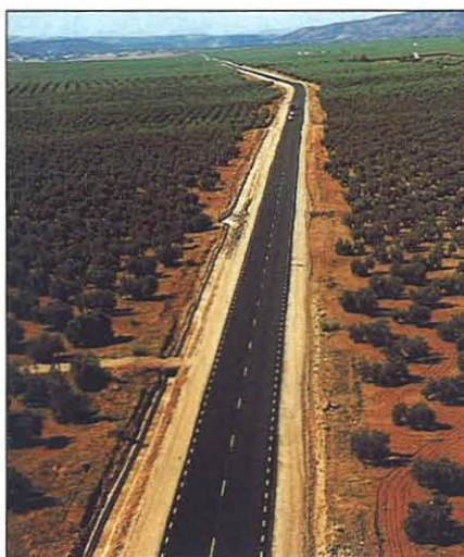
Vista de la carretera en obras. Olivares del Arroyo del Ojanco
