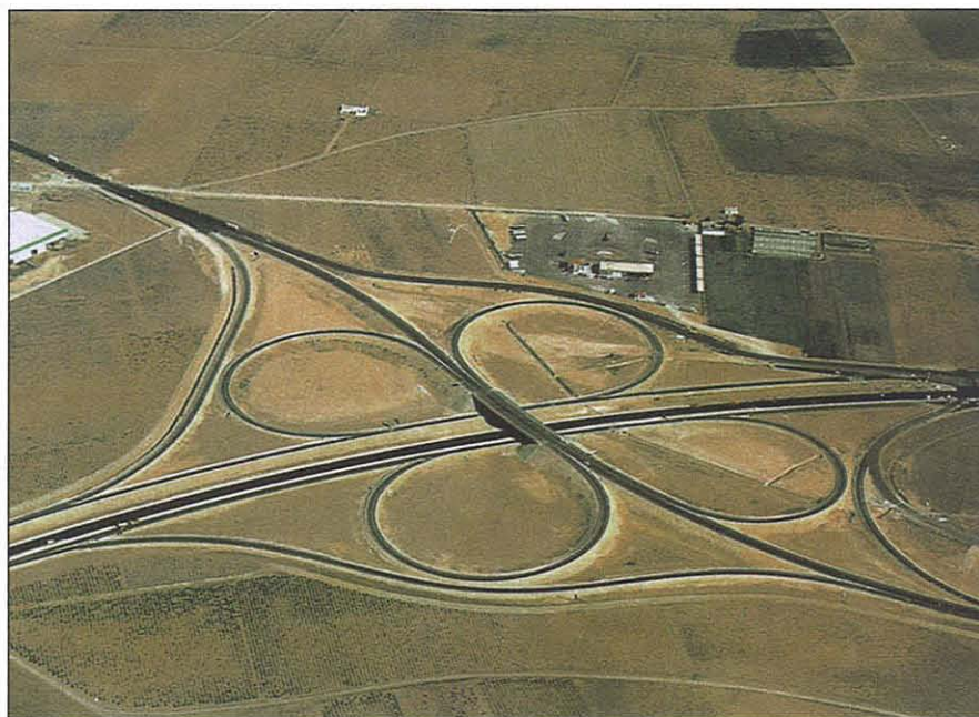
La obra tiene una longitud de 16,1 km y 25 de ramales y vías de servicio
