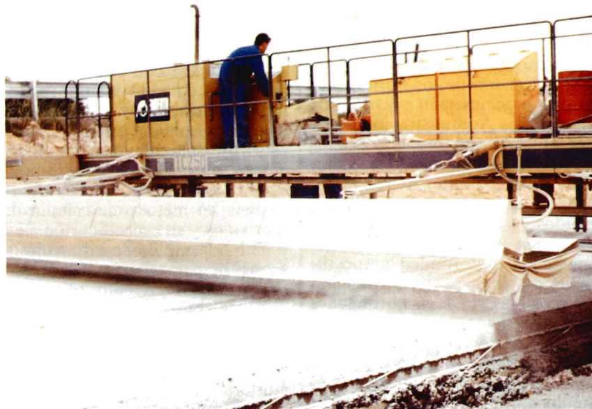
Foto 2: Aplicación del líquido filmógeno mediante su pulverización.
