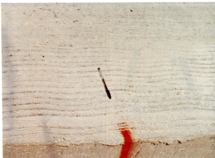
Foto 3: Detalle del producto extendido y de la textura superficial del pavimento.
