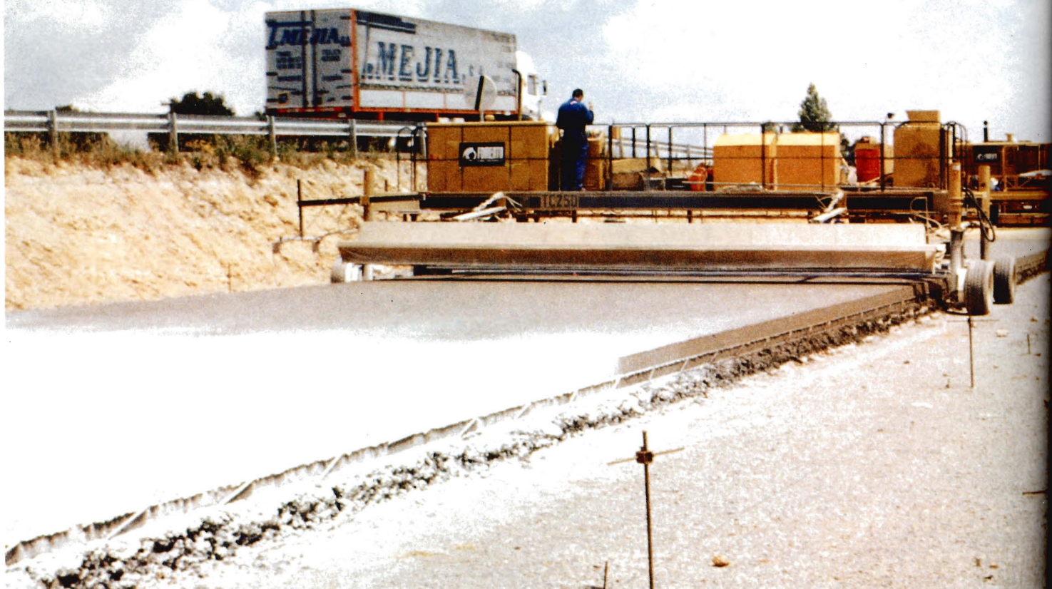
Foto 1: Empleo de productos de curado en pavimento de hormigón de la carretera N-II. P.K. 113
