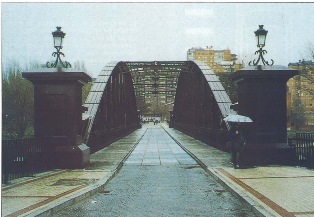
El puente reparado sigue manteniendo su belleza
