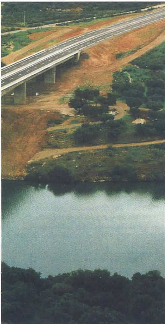
El nuevo puente sobre el Tajo tiene un vano central de 175 m, el mayor de España de sus características
