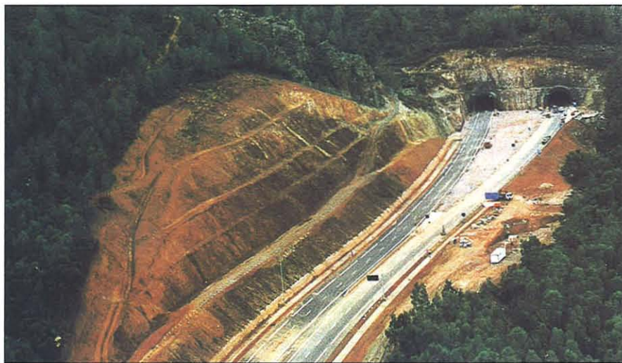
Las bocas de los túneles gemelos de Miravete, en fase de construcción
