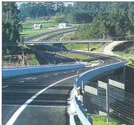
La longitud del tramo inaugurado es de 21 060 m de autovía, además de 26 700 m de ramales y caminos,
