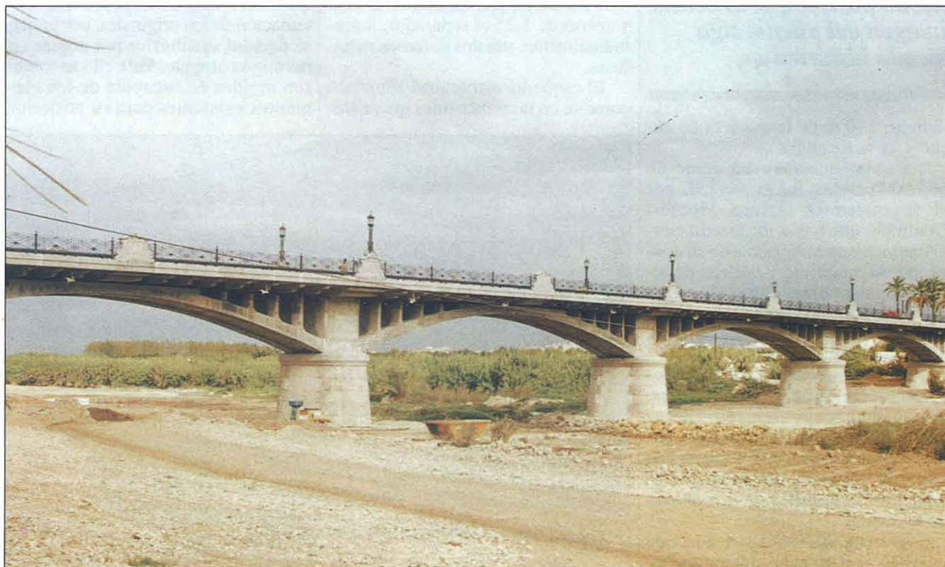
El puente dispone de un tablero con anchura total de 9,90 m, frente a los 6,00 m anteriores, que permite establecer una calzada de 6,80 m y aceras de 1,25 m
