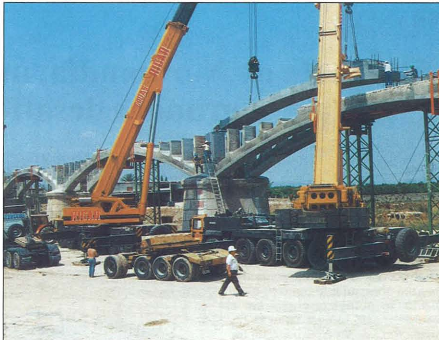
El puente en la fase de construcción
