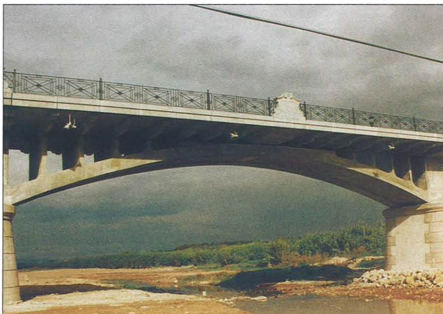
El 5 de diciembre de 1995 fue inaugurado este nuevo puente
