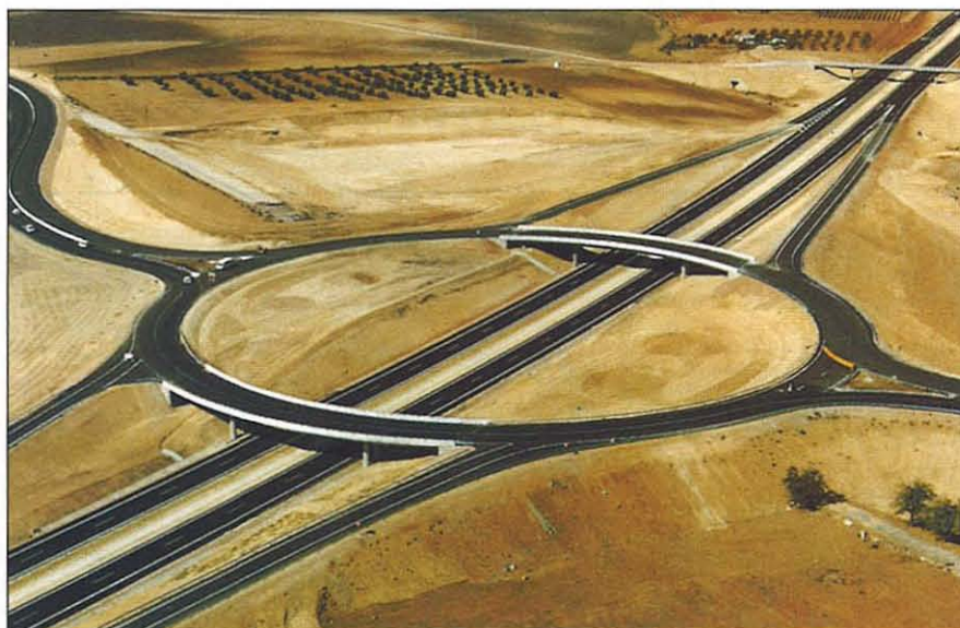
La sección de cada una de las calzadas es de 7,00 m de anchura, con arcenes exteriores de 2,50 m e interiores de 1 m.
