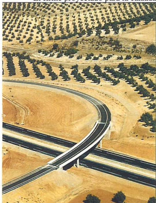
21 pasos superiores, puentes de hormigón pretensado
