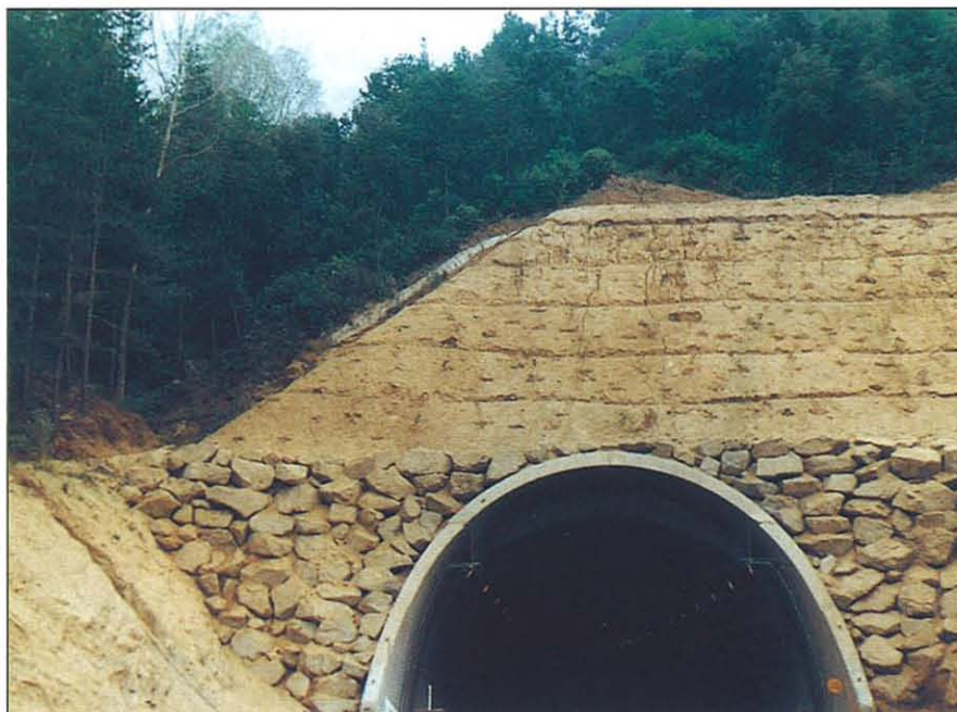
El tramo tiene una longitud total de 6 920 m, de los que 1 360 corresponden al túnel de Joanet
