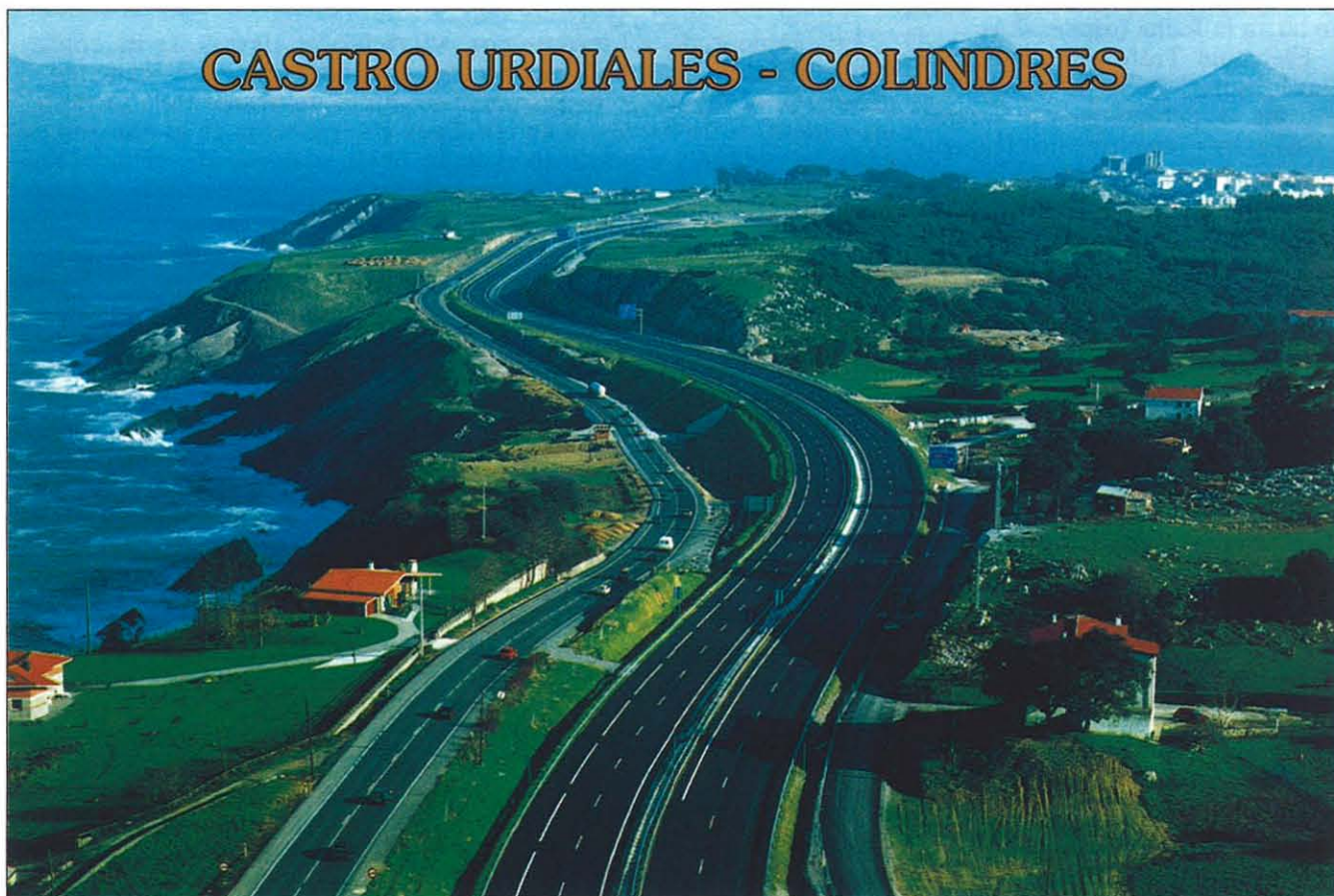
El tramo Castro Urdiales - Colindres tiene una longitud de 21 km y discurre por trazado de nueva planta.
