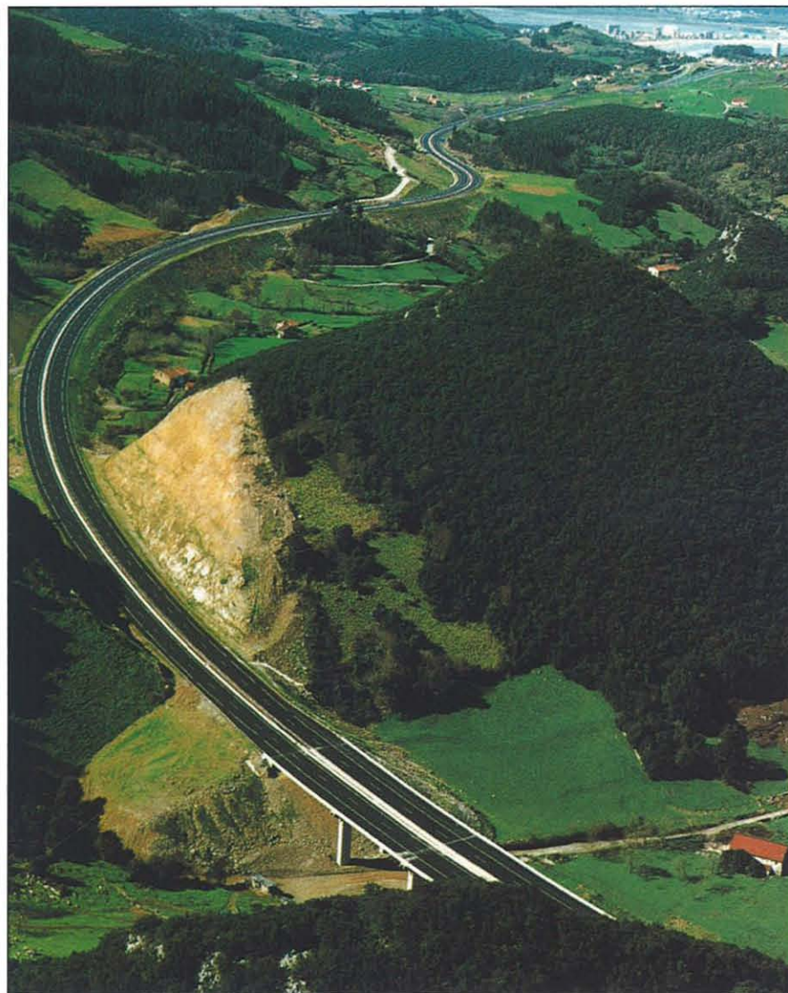
El trazado se desarrolla, en general, con curvas de radio mínimo 500 m (puntualmente hasta 400 m) y pendientes máximas del 6%.
