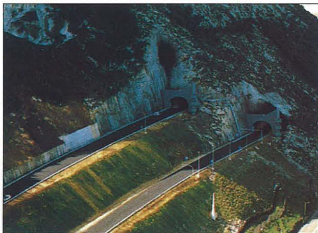
Vista parcial de las bocas de los túneles de Hoz.
