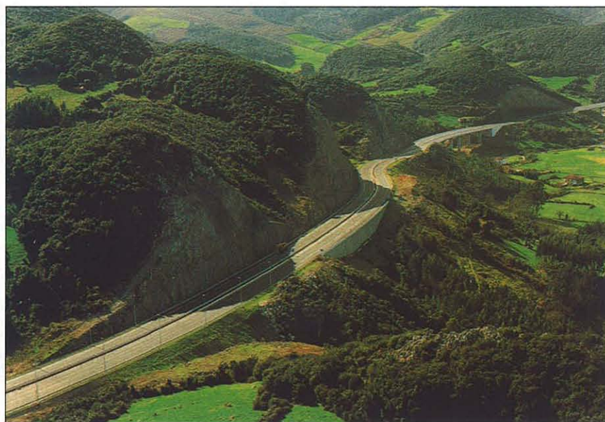
Lo accidentado del terreno ha obligado a la realización de grandes movimientos de tierras.
