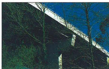
Se destacan en este tramo los viaductos sobre los ríos Aguanaz y Campiazo.
