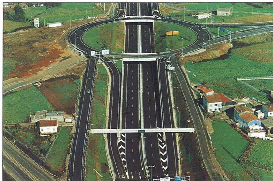
Enlace con la salida Norte de la A-9, en el tramo San Lázaro-Polig. del Tambre.
