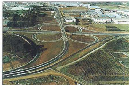
En la foto, enlace con la N-550 del tramo San Lázaro-Polig. del Tambre.
