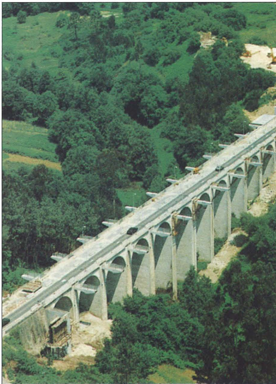
En el tramo Choupana-Enlace Sur A-9, destacan la ampliación del ancho del tablero del puente de la Rocha y el del paso sobre el ferrocarril.
