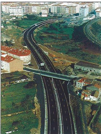
El tramo Cornes-Choupana conecta la carretera N-550 de Pontevedra con la N-525 de Orense.
