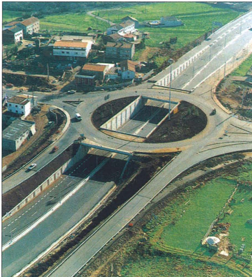
2 784 Mpta ha costado el tramo San Lázaro Fontiñas (Sur), de 2687 m de longitud.
