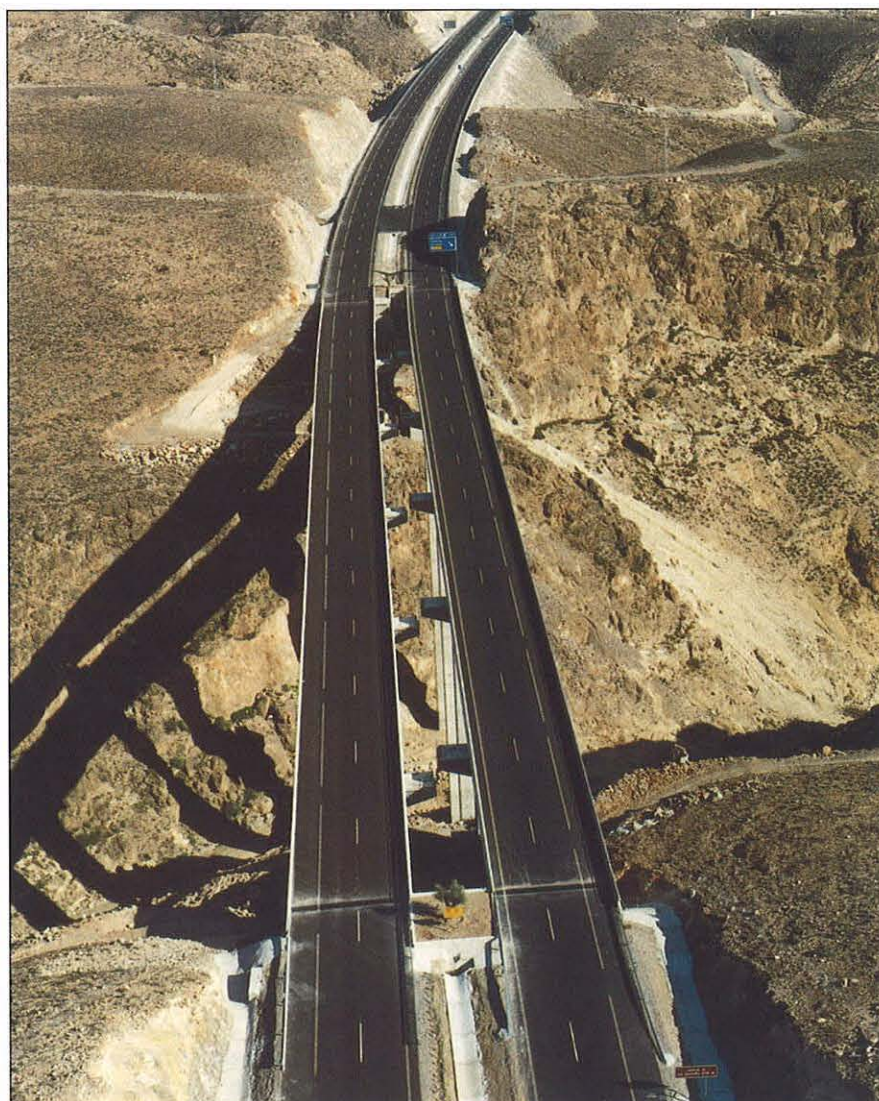
El tramo inaugurado consta de 10,2 km de longitud, destacándose entre sus estructuras los viaductos dobles de El Palmar y la Garrofa y los tres túneles realizados.
