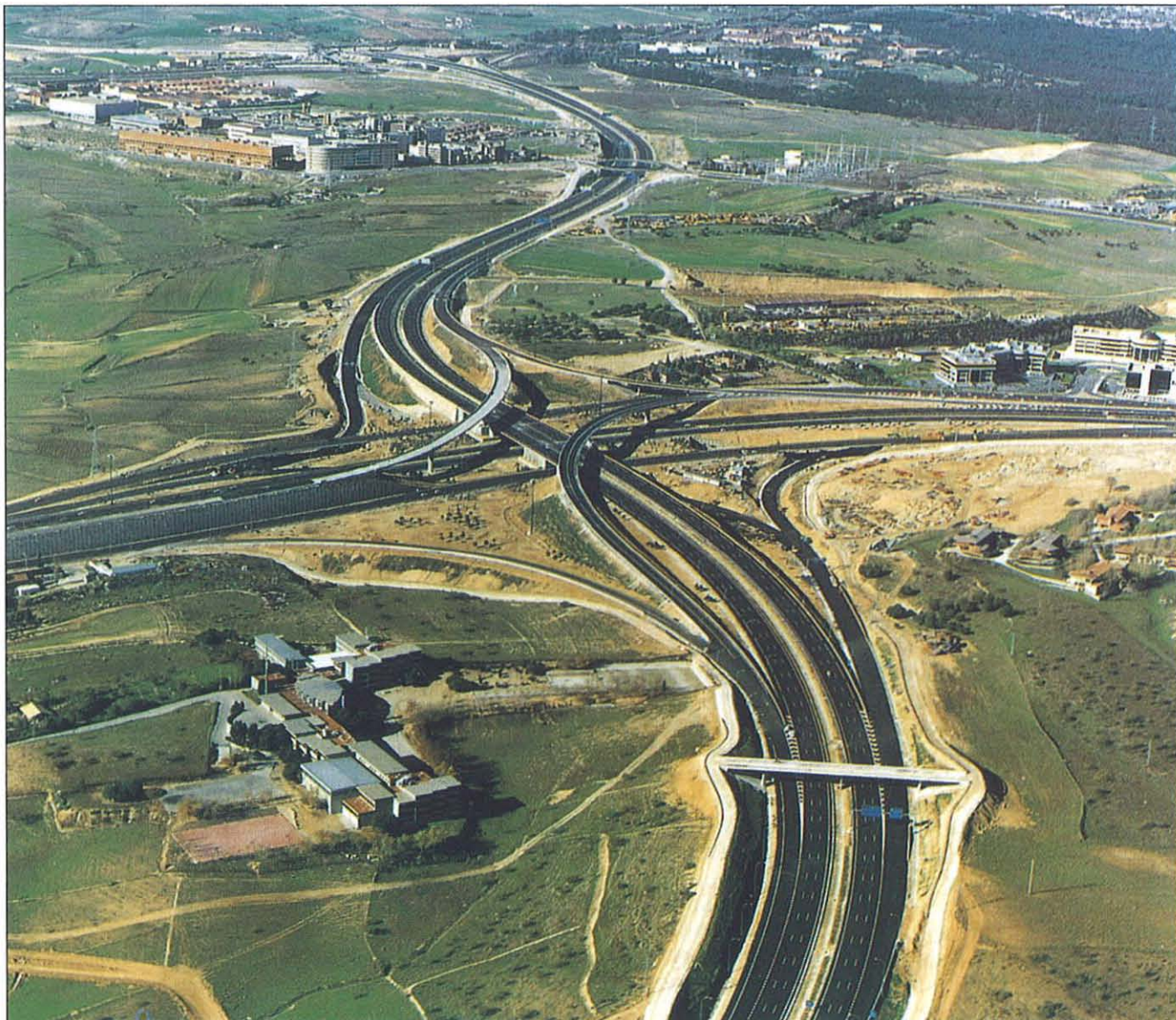
Este tramo sirve de enlace entre la carretera C-607 de Madrid a Colmenar y la Vía Borde de Hortaleza. En la foto, enlace nº 2: Burgos.
