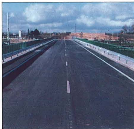
La nueva carretera dispone de una calzada de 7 m, con arcenes de 1,50 m.
