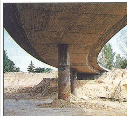
En la foto, Nudo de El Barrial. Detalle del proceso constructivo.
