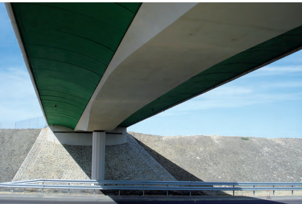
Detalle de la estructura E4
