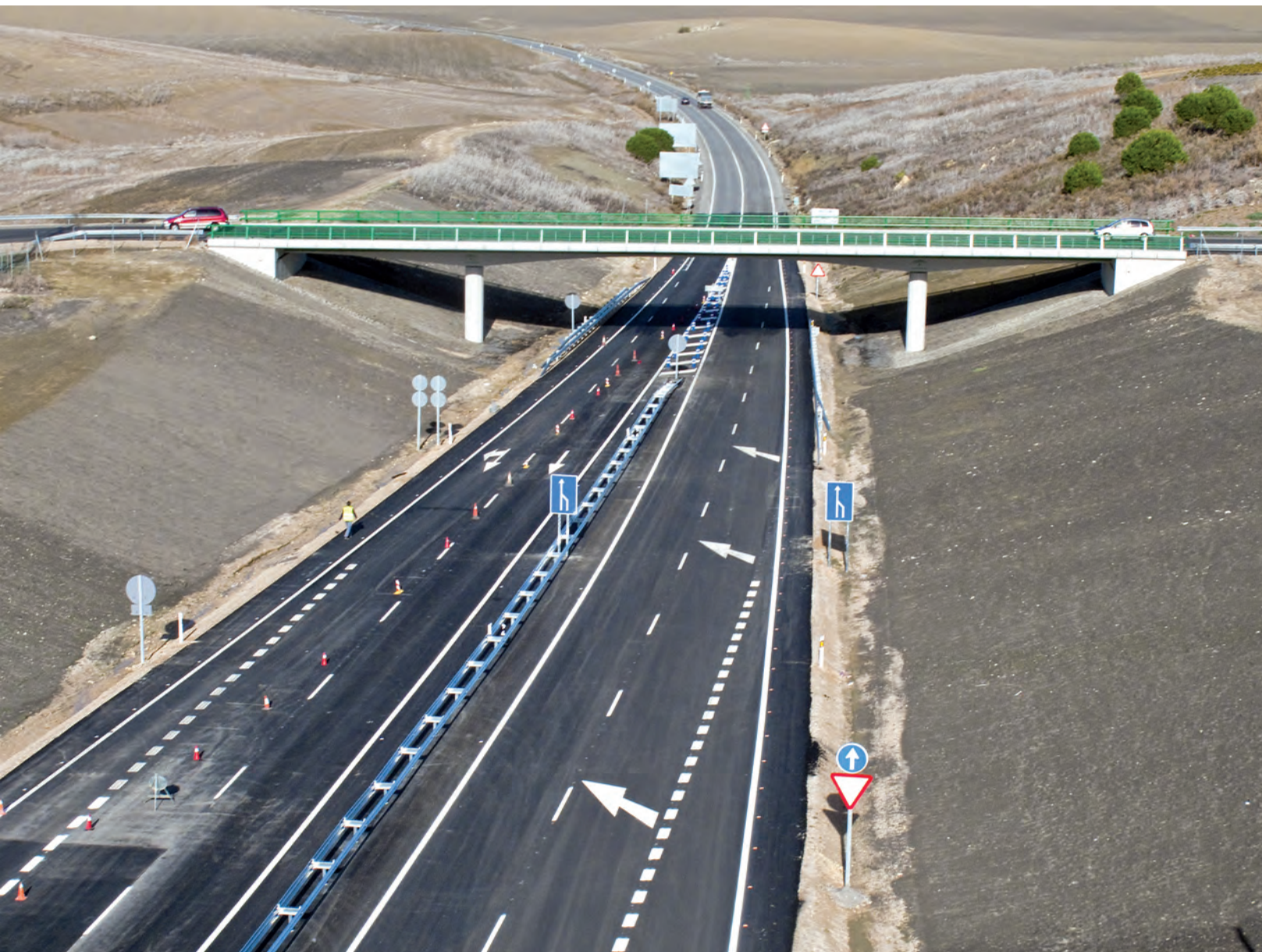
Estructura E4. Paso superior A-471
