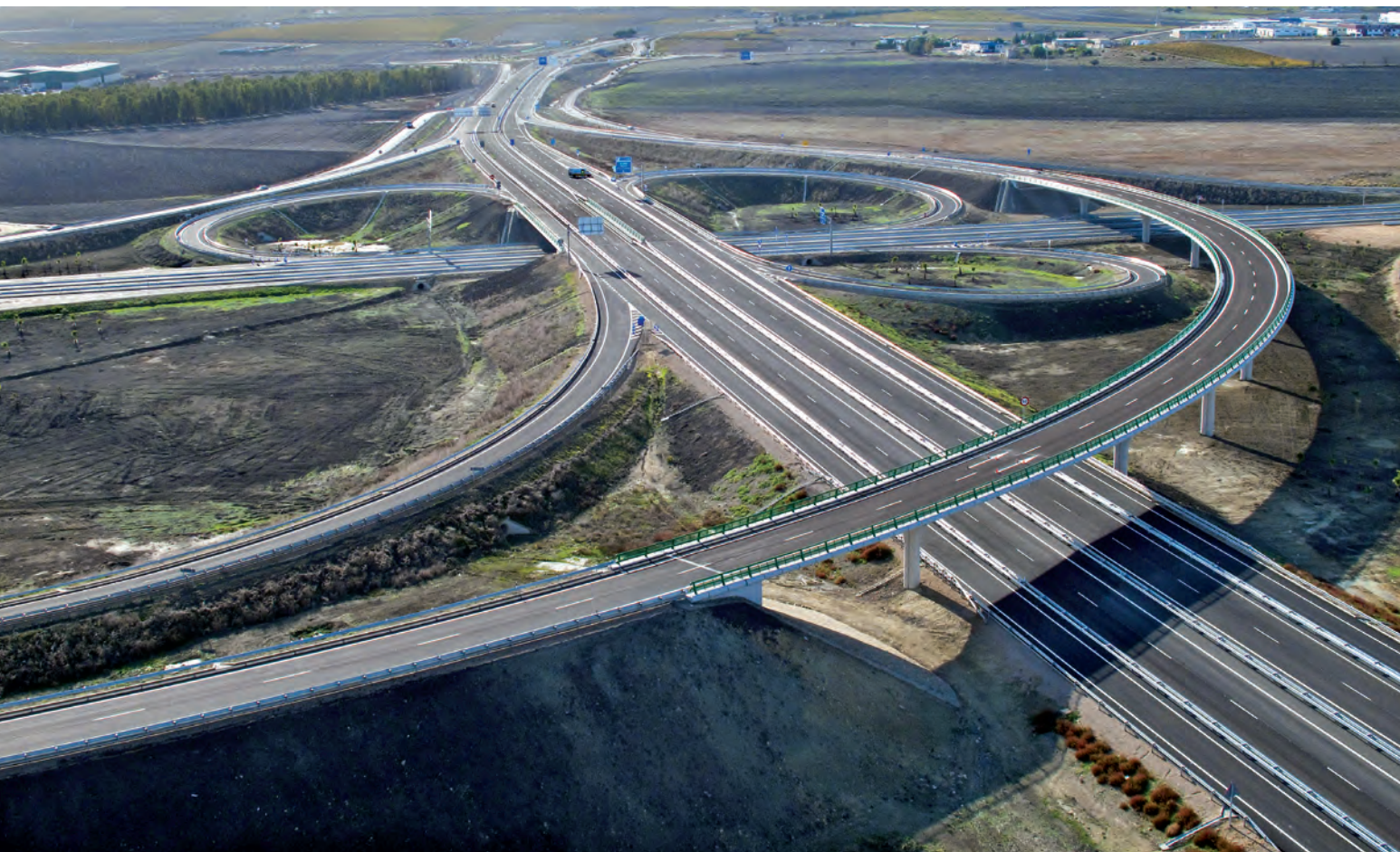
Vista panorámica del viaducto (estructura E3)
