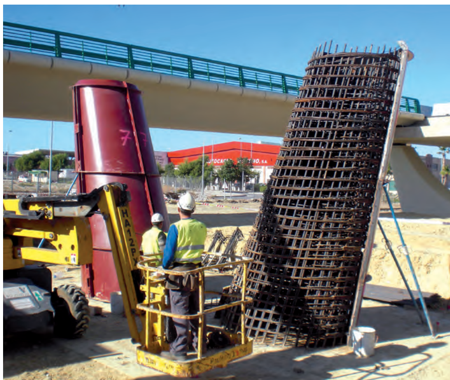
Detalle del encofrado y del acero en pilas
