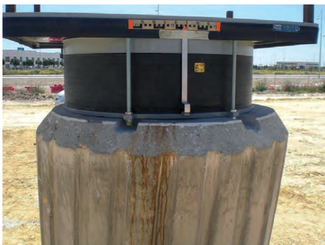
Detalle de apoyo deslizante en pilas
