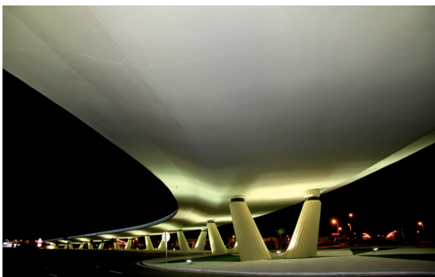
Visión nocturna de las pilas iluminadas
