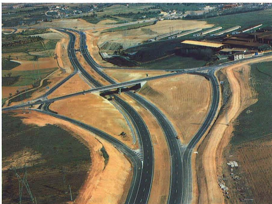
Vista general del tramo Cigales-Arroyo, el cual dispone de 16 estructuras, y soluciona la continuidad de la autovía, derivando la circulación de Valladolid.
