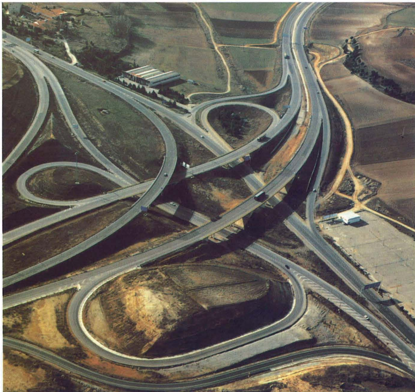
En la foto, Nudo de El Landa, vistosa obra singular distribuidora de la circulación de la N-1, N-620 y circunvalación de Burgos.
