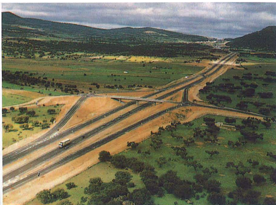
A medida que se iba construyendo la autovía, se ha ido controlando la regularidad superficial de los pavimentos. En la foto, enlace de apertura en el tramo Trujillo-Miajadas.
