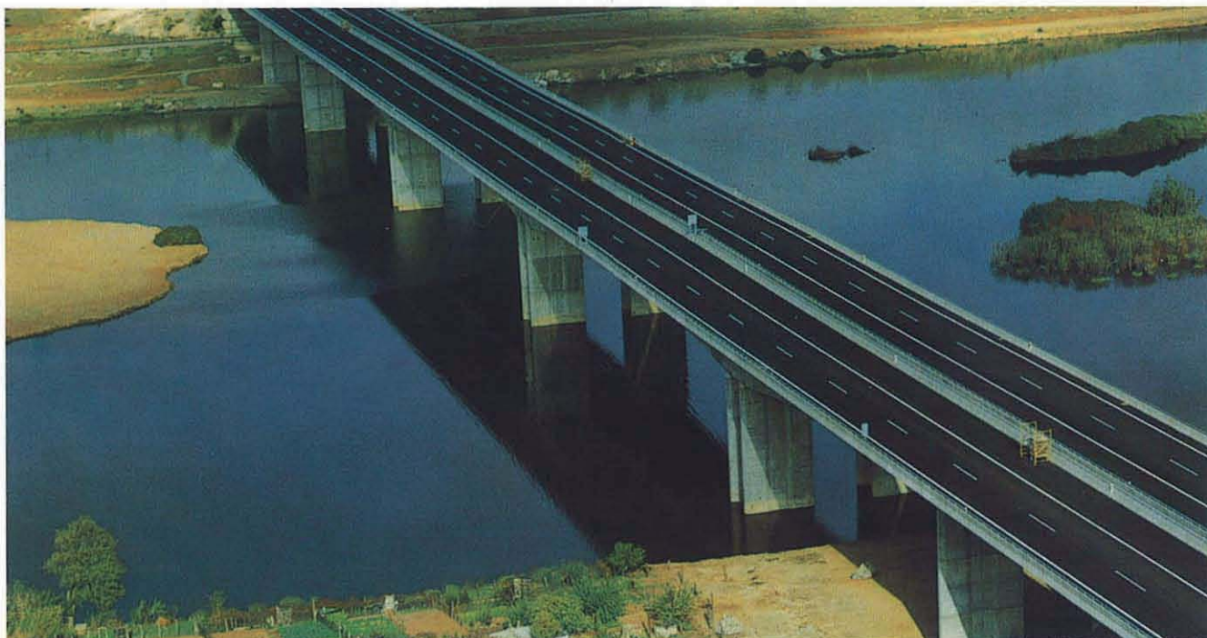
Puente sobre el río Guadiana, formado por dos tableros de 13,60 m de ancho y 552 m de longitud, con luces de 46, 60, 100, 100, 60, 46 y 40. La cimentación de las pilas se ha realizado por medio de pilotes de 1,50 m de diámetro empotrados en roca para los afectados por el cauce, directa para los situados en el extremo.
