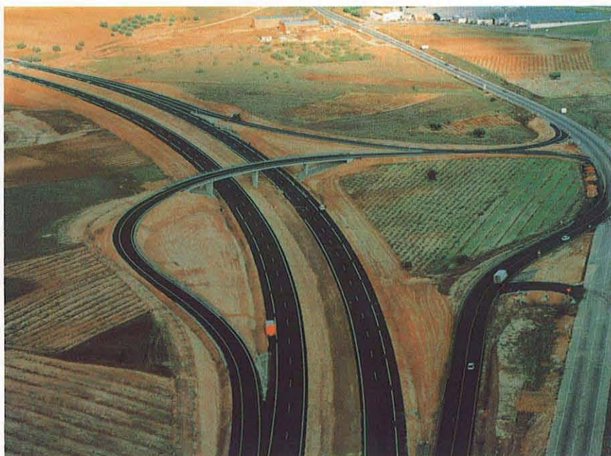
En la realización de esta obra se han realizado más de 1 000 000 de m 3 de desmonte y 600 000 de terraplén, empleándose 106 000 toneladas de mezclas bituminosas.
