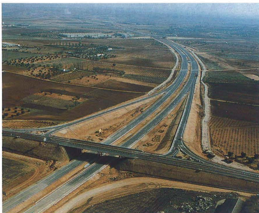
A lo largo de la Variante, se han construido 6 estructuras de pasos superiores con losas postesadas "in situ" y una estructura de paso inferior con vigas prefabricadas doble T.
