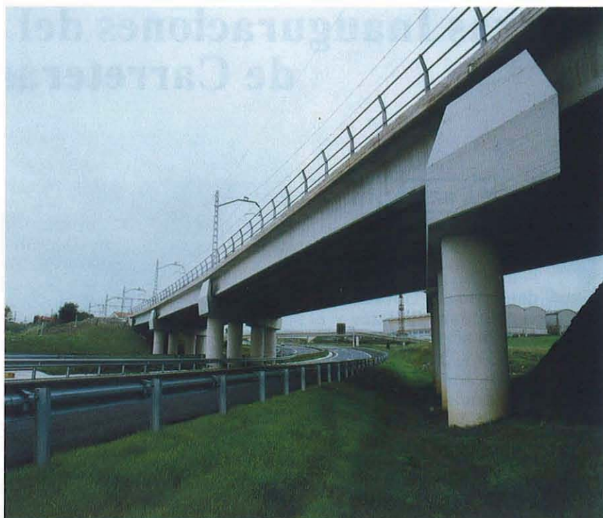
Las estructuras más singulares del tramo inaugurado en la autovía del Cantábrico son dos viaductos que salvan los valles del arroyo de Cubón y del río Miera, de 226 y 411 m de longitud, respectivamente.
