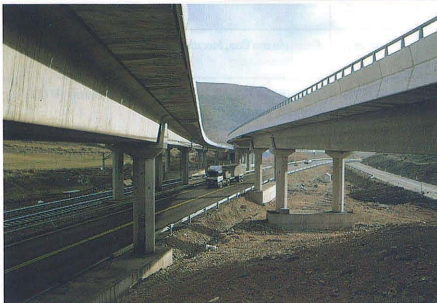
La Variante Medinaceli ha sido especialmente difícil debido a problemas geológicos-geotécnicos.
