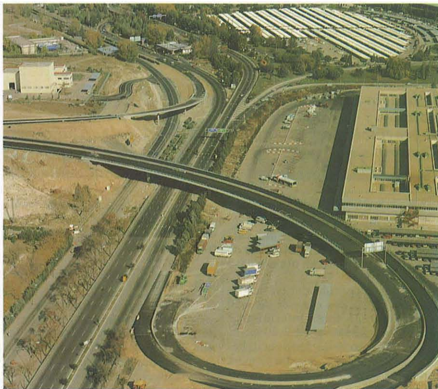
El acceso tiene 6,5 km de longitud en su tronco principal y 4 km de ramales.
