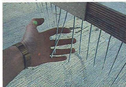
Foto 7 Peine de púas plásticas para la generación de la macrotextura
