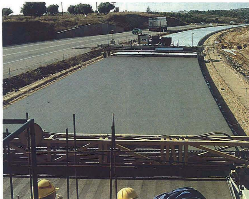
Foto 8 Textura y curado del pavimento de hormigón
