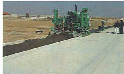
Foto 14 Extendido del arcén exterior de hormigón
