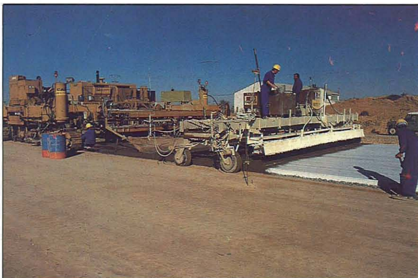
Foto 1 Extendido de la base de hormigón magro
