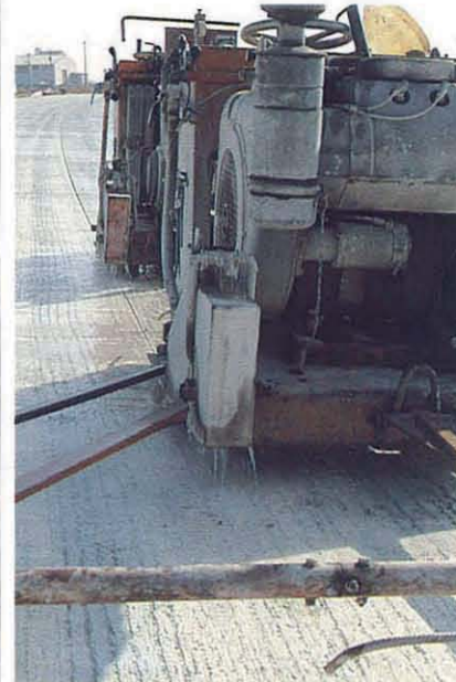
Foto 11 Aserrado de la junta longitudinal
