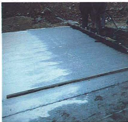
Foto 13 Regla de aluminio de 3 m para la realización de la junta de construcción
