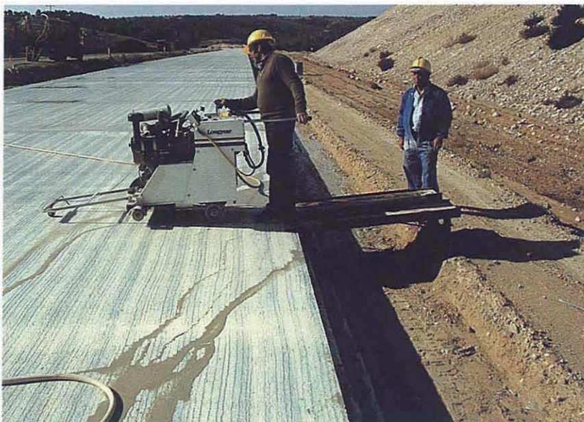
Foto 9 Aserrado de la junta transversal
