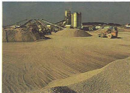
Foto 2 Central de fabricación. Preacopio de todos los áridos
