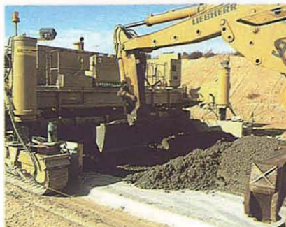
Foto 5 Preextendido del hormigón de pavimento con la ayuda de una retroexcavadora de cazo ancho
