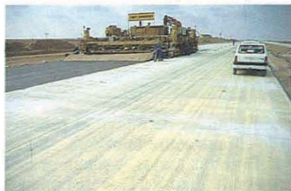
Foto 15 Extendido del carril lento de hormigón
