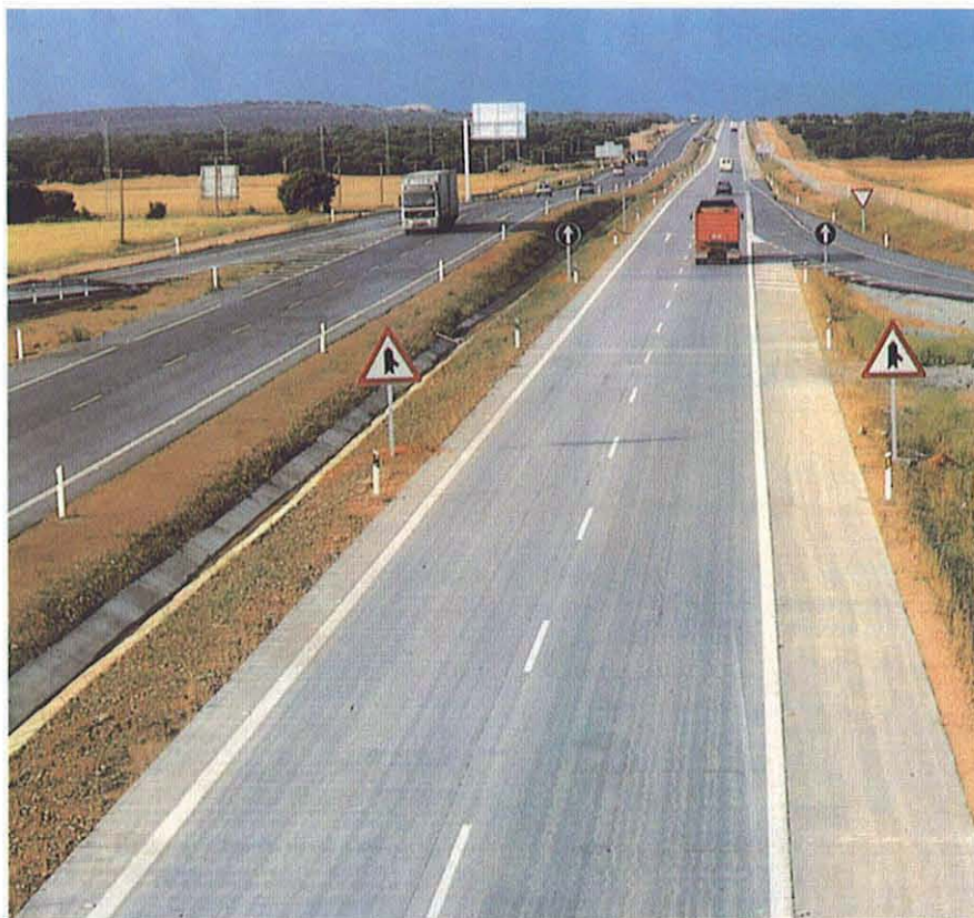
En este tramo se ha utilizado hormigón magro y vibrado.
