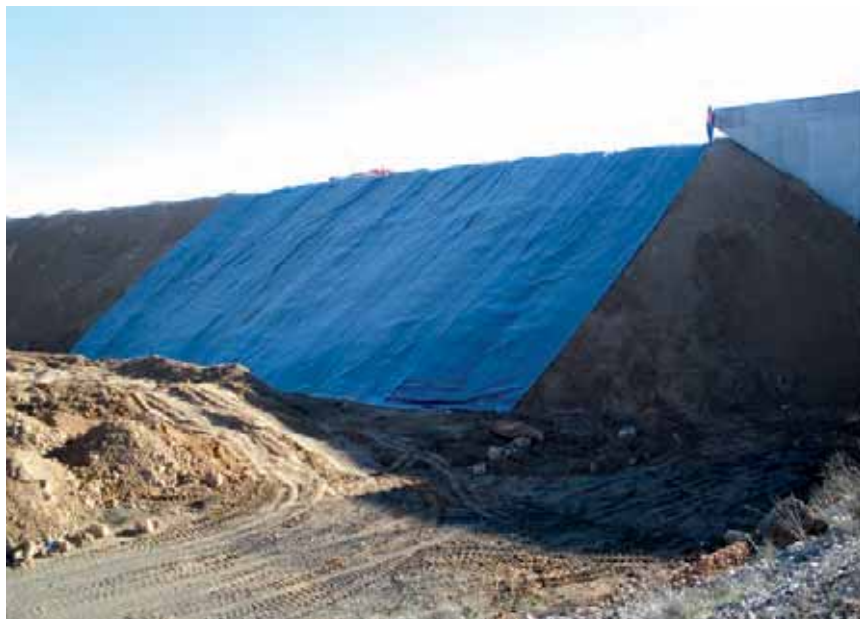
Figura 6. Detalle de la impermeabilización del talud de un paso a nivel en la localidad de Puebla de Híjar (Teruel)
