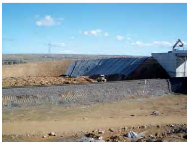
Figura 5. Impermeabilización de los taludes de la supresión de pasos a nivel en la localidad de Puebla de Híjar (Teruel)
