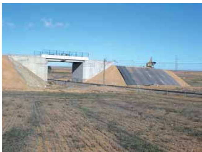
Figura 5. Impermeabilización de los taludes de la supresión de pasos a nivel en la localidad de Puebla de Híjar (Teruel)
