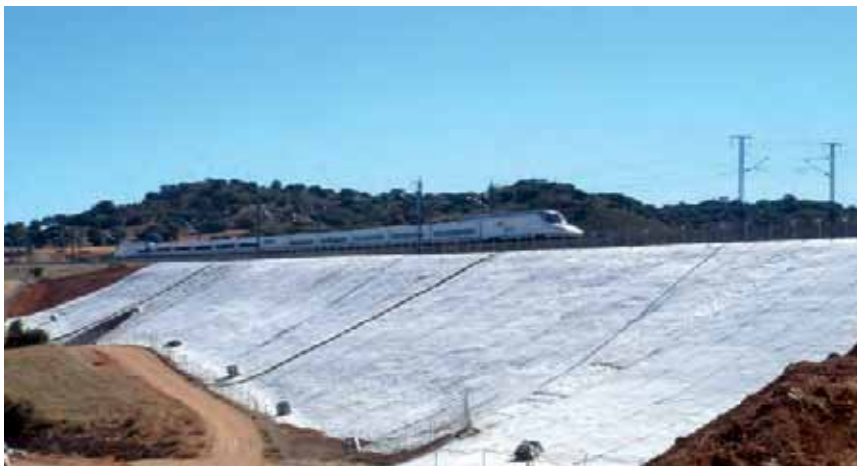
Figura 4. Barreras geosintéticas arcillosas en un talud
