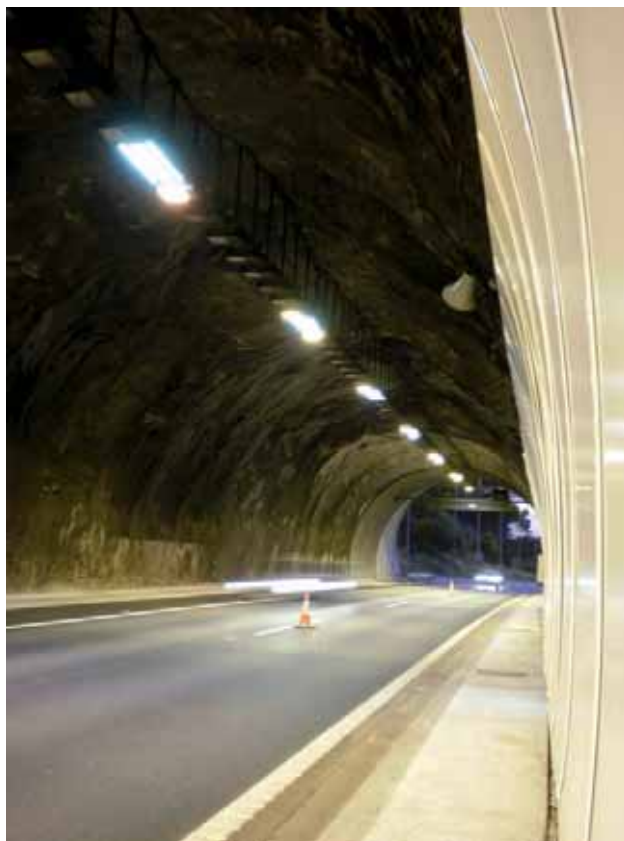
Figura 8. Vista interior de los Túneles de Parpers
