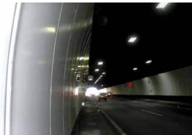
Figura 5. Vista interior de los Túneles de Parpers
