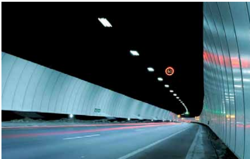
Figura 2. Vista interior de los Túneles de Parpers
