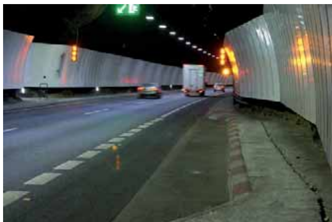
Figura 4. Vista interior de los Túneles de Parpers
