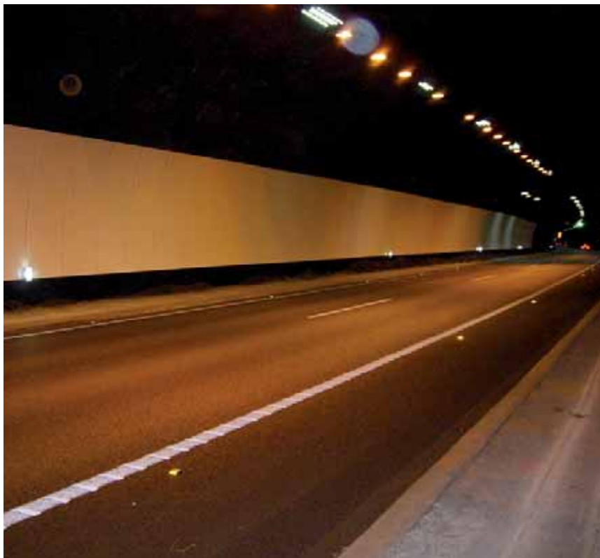
Figura 6. Vista interior de los Túneles de Parpers
