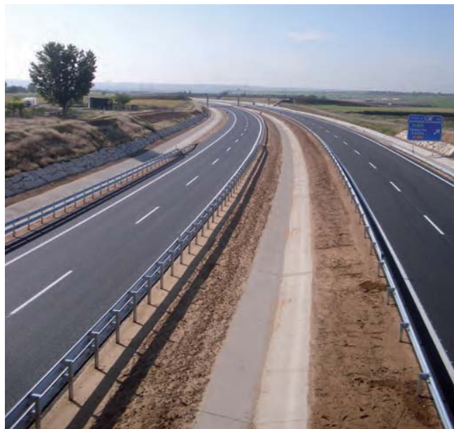
Sección transversal del tronco en desmonte
