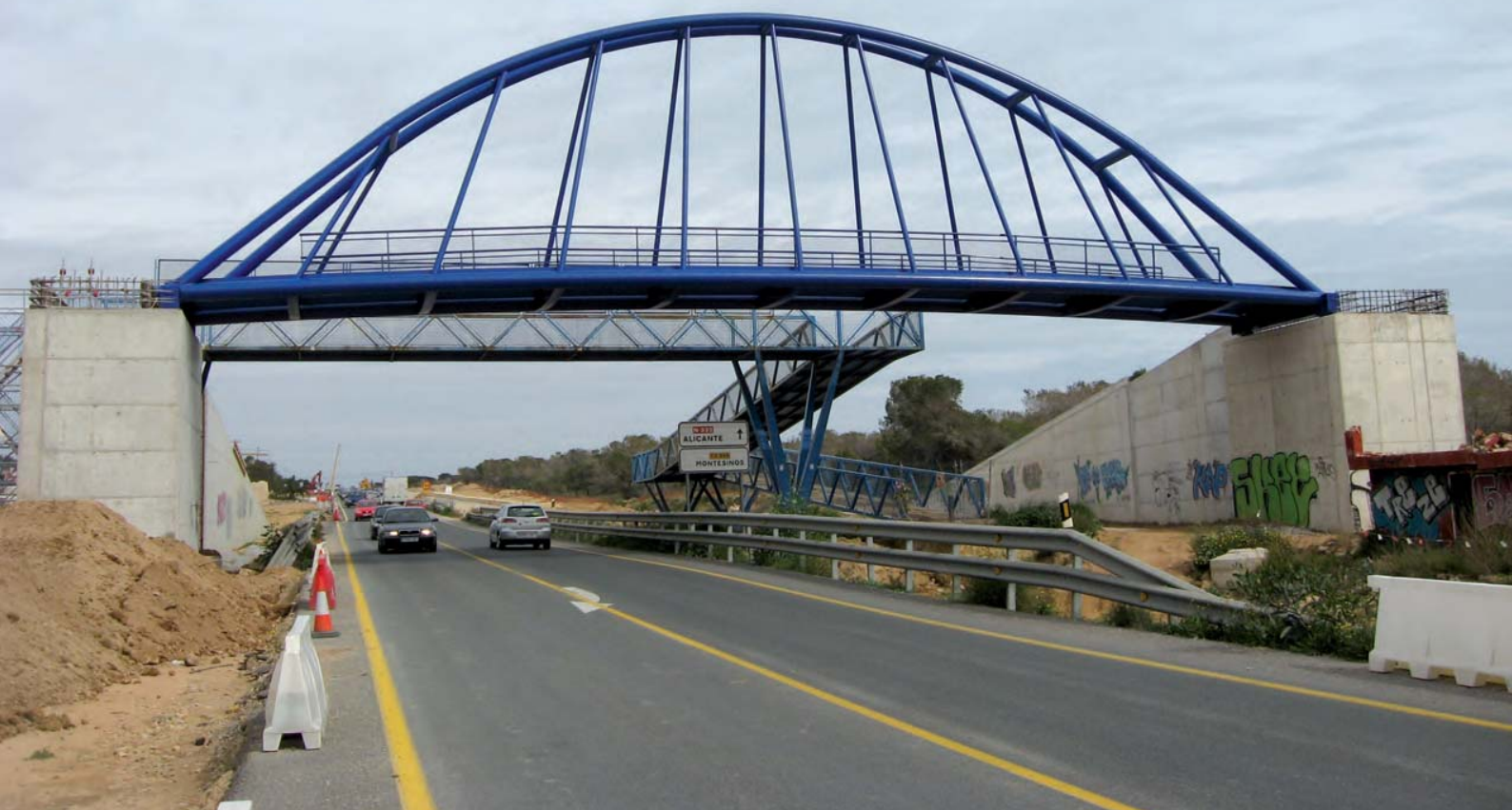
Sustitución de pasarela peatonal
