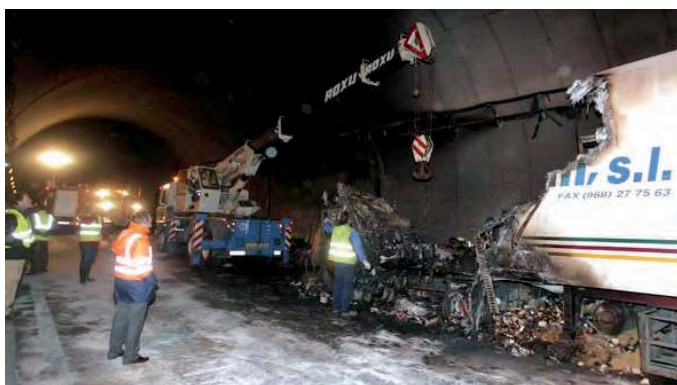
Figura 4. Daños en el túnel del Negrón después del incendio de un camión en 2008 (Palazón y López, 2010)
