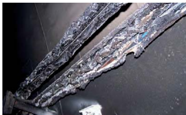
Figura 4. Daños en el túnel del Negrón después del incendio de un camión en 2008 (Palazón y López, 2010)
