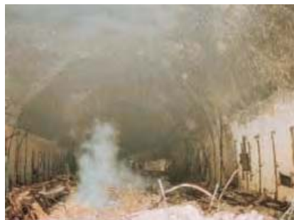
Figura 1. El túnel Nihonzaka después del incendio (Mashimo y Mizutani, 2003)
