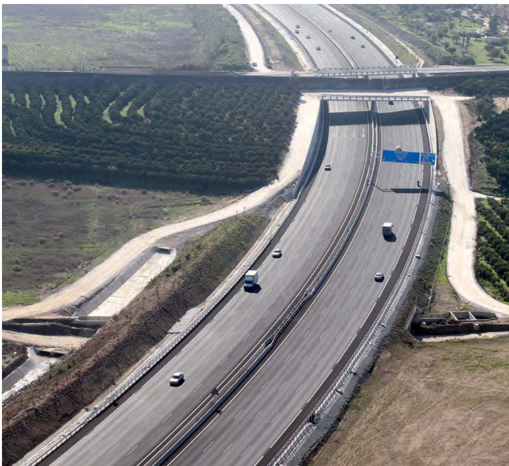
A lo largo del tramo 2 se han dispuesto 3 pasos inferiores, 2 pasos superiores y 2 viaductos de grandes dimensiones
