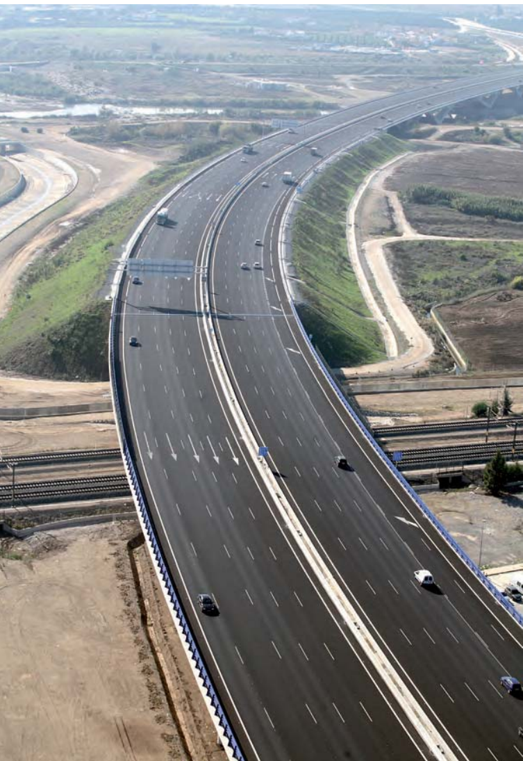
Viaducto sobre la Línea de Alta Velocidad Córdoba-Málaga
