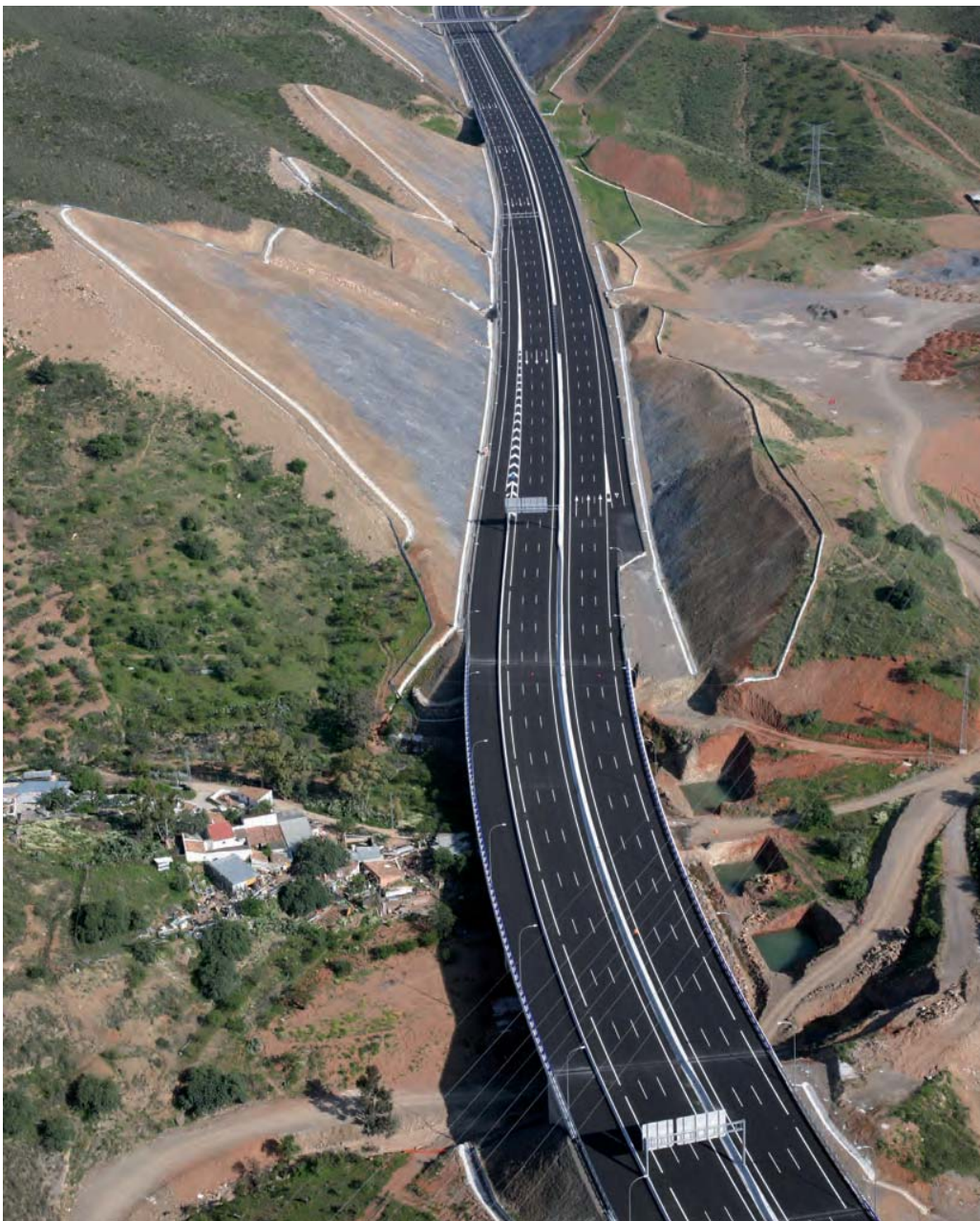
El tramo 4 tiene una longitud de tronco de 6,31 km y supuso una inversión aproximada de 91,66 millones de euros
