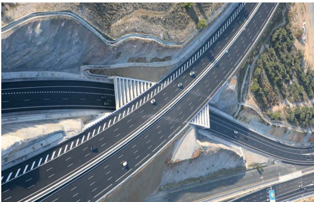
Pérgola de conexión con la Autopista AP-7
