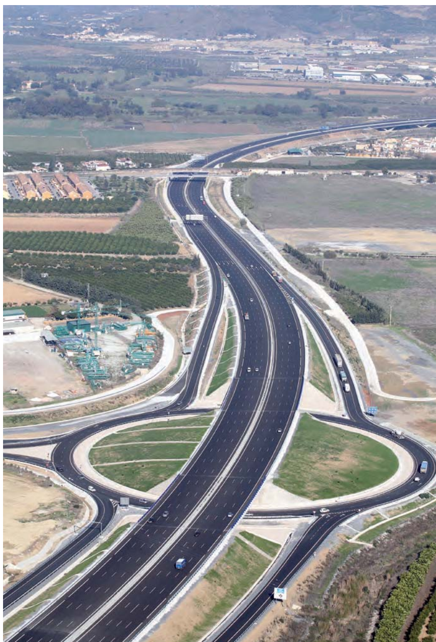
Enlace 2 con glorieta central inferior a distinto nivel (tramo 2)
