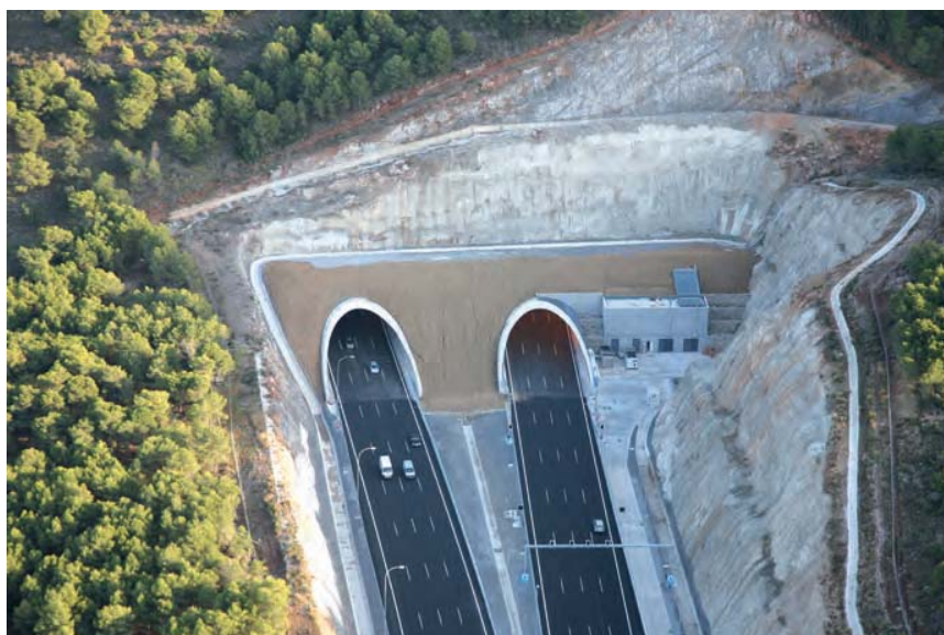
Túnel de Churriana
