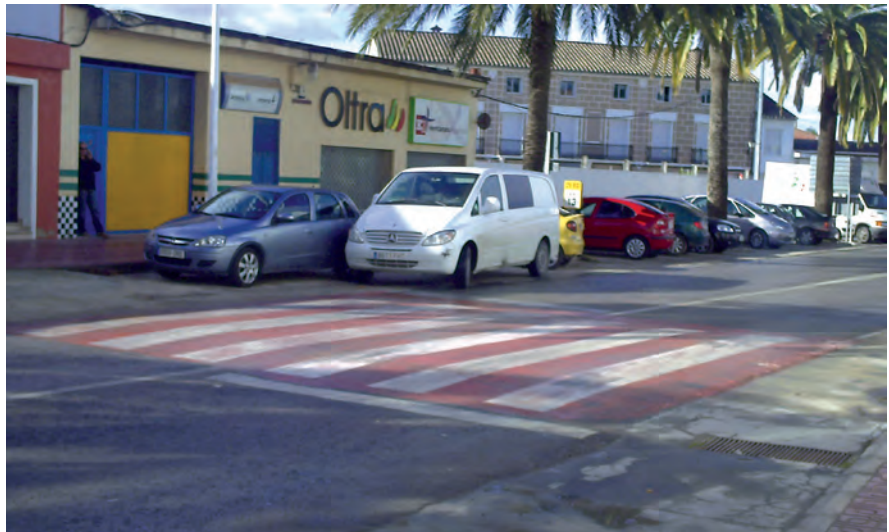
Figura 1. Paso peatonal elevado en Quatretonda (Valencia)
