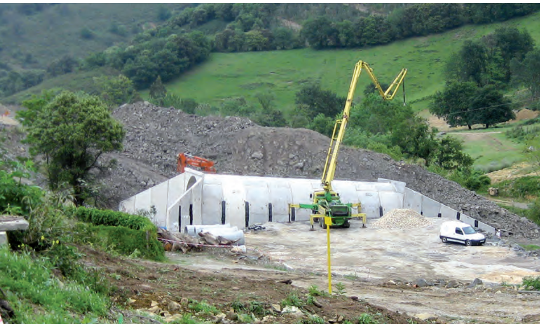
Paso interior mediante estructura prefabricada
