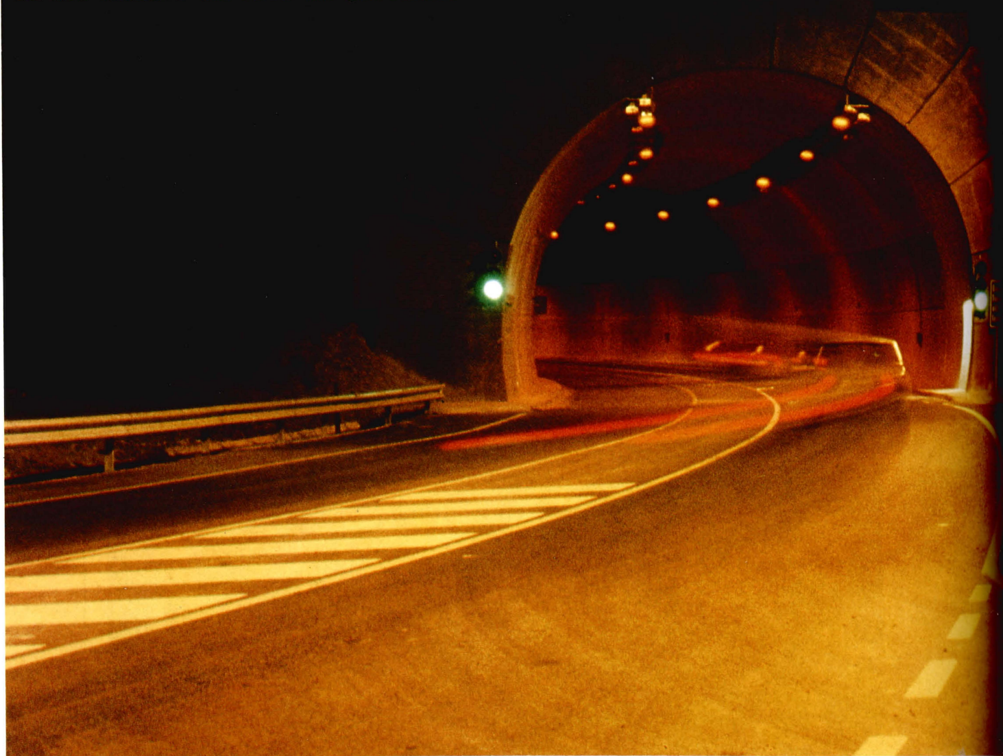
Foto 1: Boca Sur del túnel
