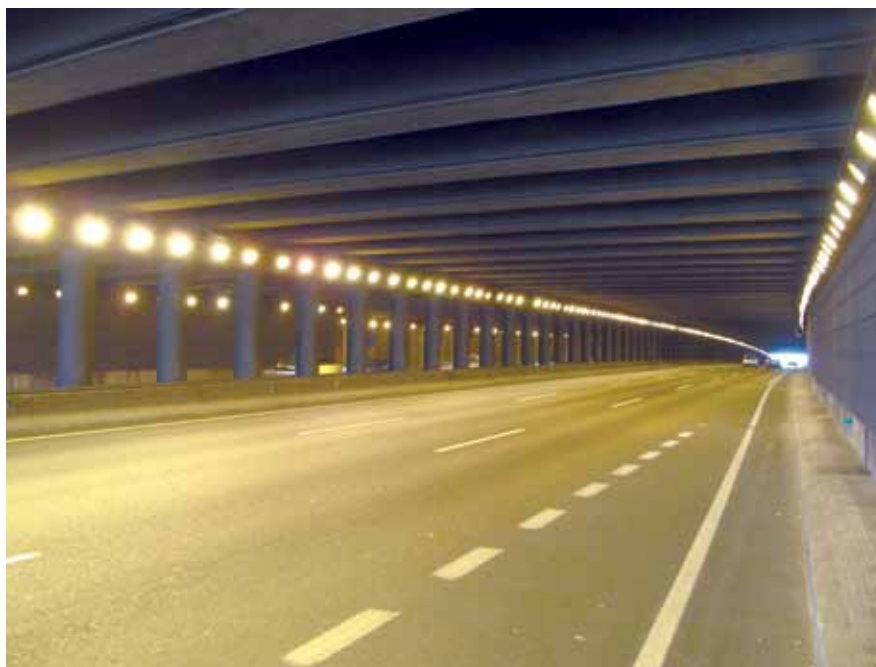
Figura 1. Interior túnel de carretera
