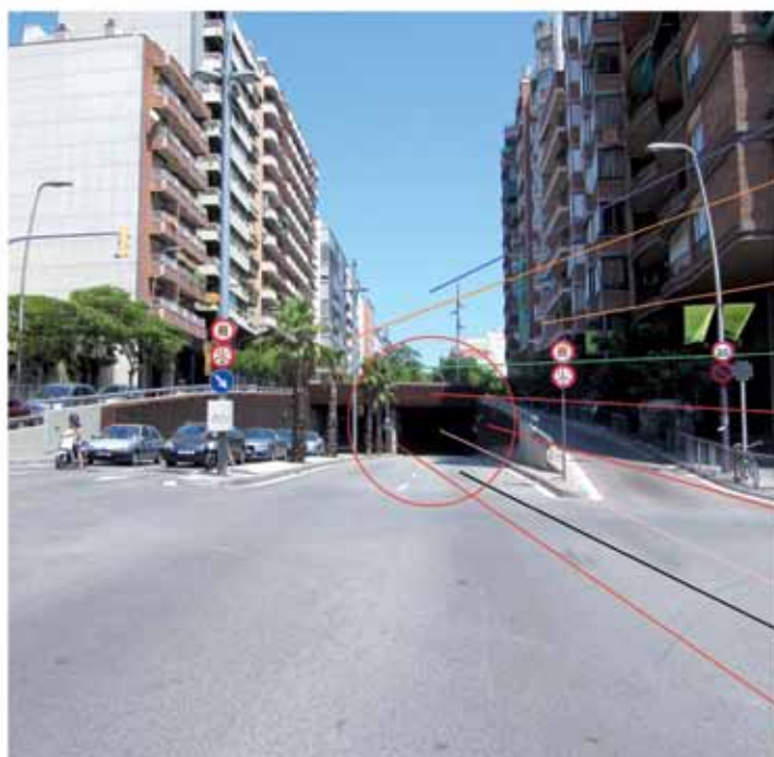
Figura 11. Mediciones luminotécnicas y cono visión 20° a escala en boca entrada Oeste del túnel D
