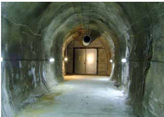
Foto 2. Galería de evacuación
