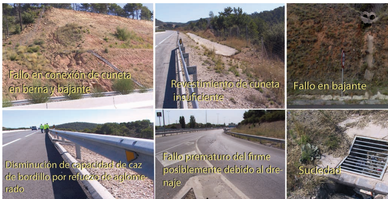
Figura 1: Detalles de fallos relativamente frecuentes en el drenaje de la plataforma y márgenes.
