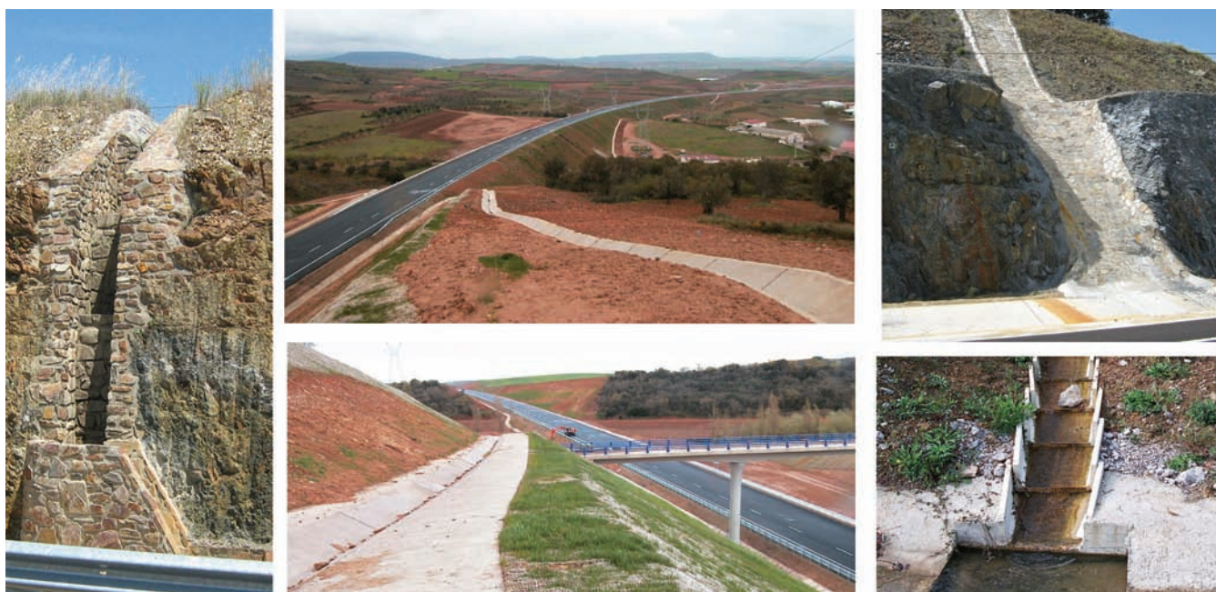
Figura 2: Detalles de construcción cuidadosa en el drenaje de la plataforma y márgenes.
