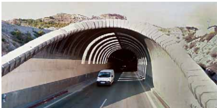
Figura 7: Túnel de Lorca (Murcia).
