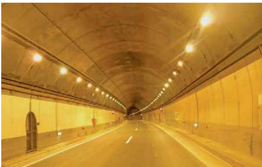
Figura 3: Iluminación de túnel con proyectores instalados en disposición bilateral. *Imagen correspondiente al interior del túnel de Lorca de la Autovía A-7.
