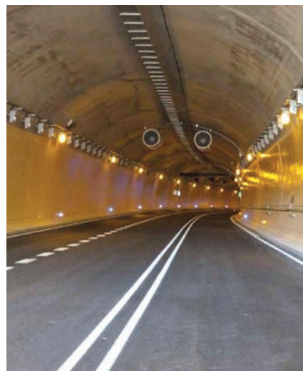
Figura 13. Túnel de Petralba N-260 (VSAP).
