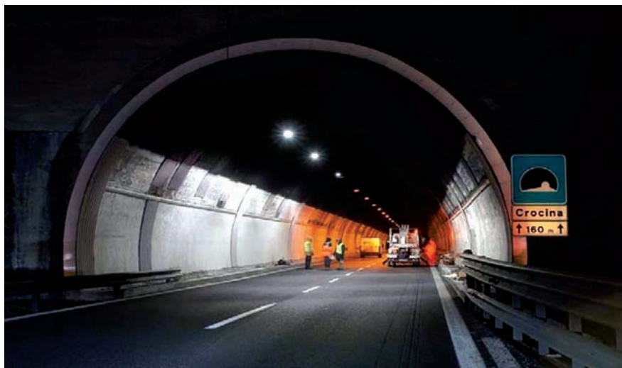
Figura 12. Túnel de Crocina. Italia (Led y VSAP).
